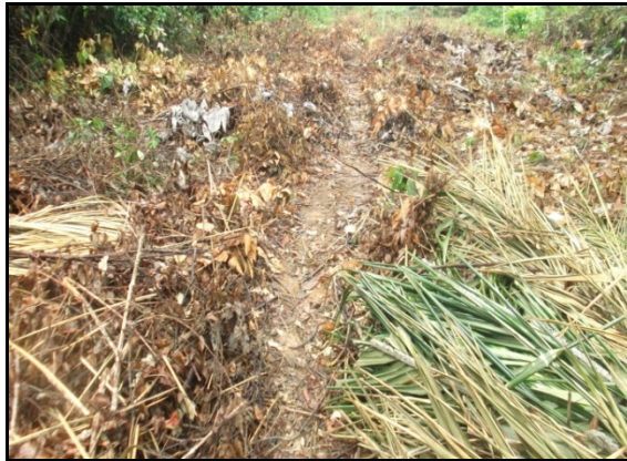
Figura 7-33 - Trilha mantida sem o material lenhoso picado e rebatido no solo visando facilitar o caminhamento das equipes pela faixa de serviço.
