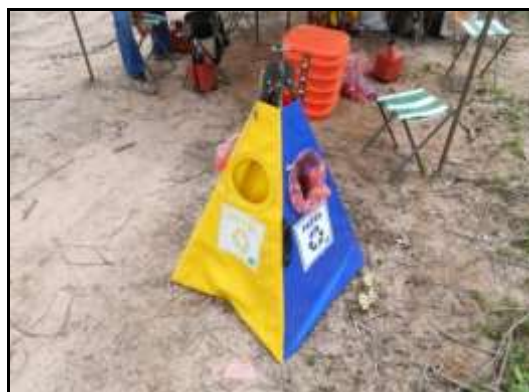
Figura 7-2 - Exemplo de recipiente para coleta seletiva de resíduos nas frentes de obras.
