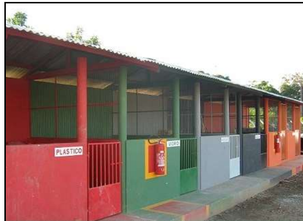
Figura 7-3 – Baias de armazenamento temporário de resíduos, identificadas de acordo com a Resolução CONAMA nº 275/01.
