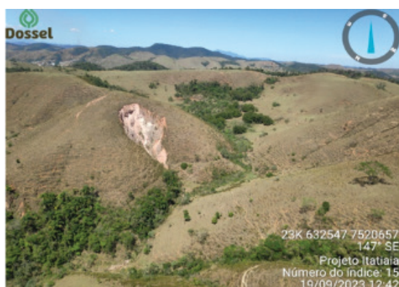
Voçoroca em meia encosta causada pela remoção da vegetação em área de alta declividade.
