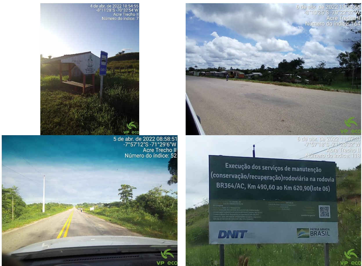
Figura 6.121 – Infraestruturas viárias e condições das estradas da região do empreendimento, com destaque para a BR-364.
