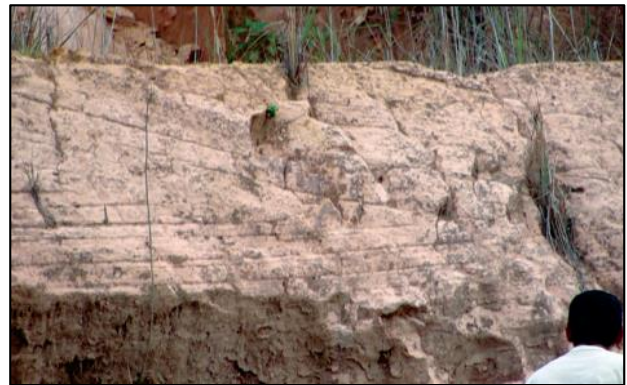
Figura 6.7 - Vários tipos de ocorrências dos sedimentos da formação Solimões ao longo da rodovia BR-364 (municípios de Cruzeiro do Sul e Rio Branco). Fotografia: Ruy Benedito Calliari Bahia, 2012, apud CPRM, 2015.
