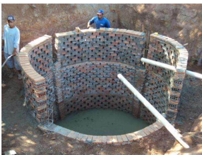
Figura 21: Construção de fossa séptica.
