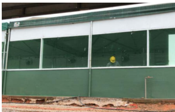
Figura 9- Telamento no refeitório do Canteiro de Obras de Feijó
