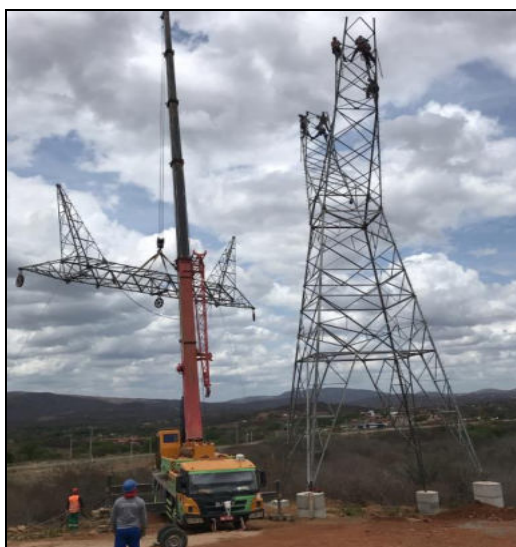
Figura 3 - Montagem de painéis superiores.
