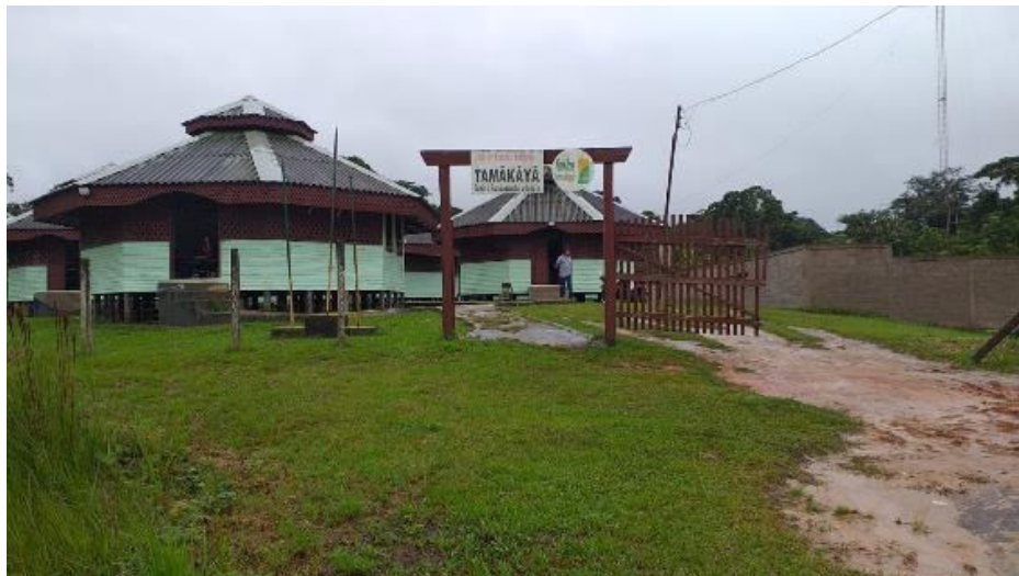
Fotografia 1. Escola Estadual Indígena Tamã Kayã, observar a falta de muro ou cerca, Terra Indígena Katukina/Campina. Fotografia: Leslye Ursini, 2022.
