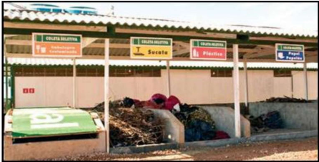
Figura 15: Espaço para acondicionamento de resíduos no canteiro de obras.
