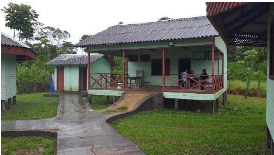
Fotografia 5. Cantina para a merenda escolar e sanitários na Escola Estadual Indígena Tamã Kayã da Terra Indígena Katukina/Campina. Fotografia: Leslye Ursini, 2022.
