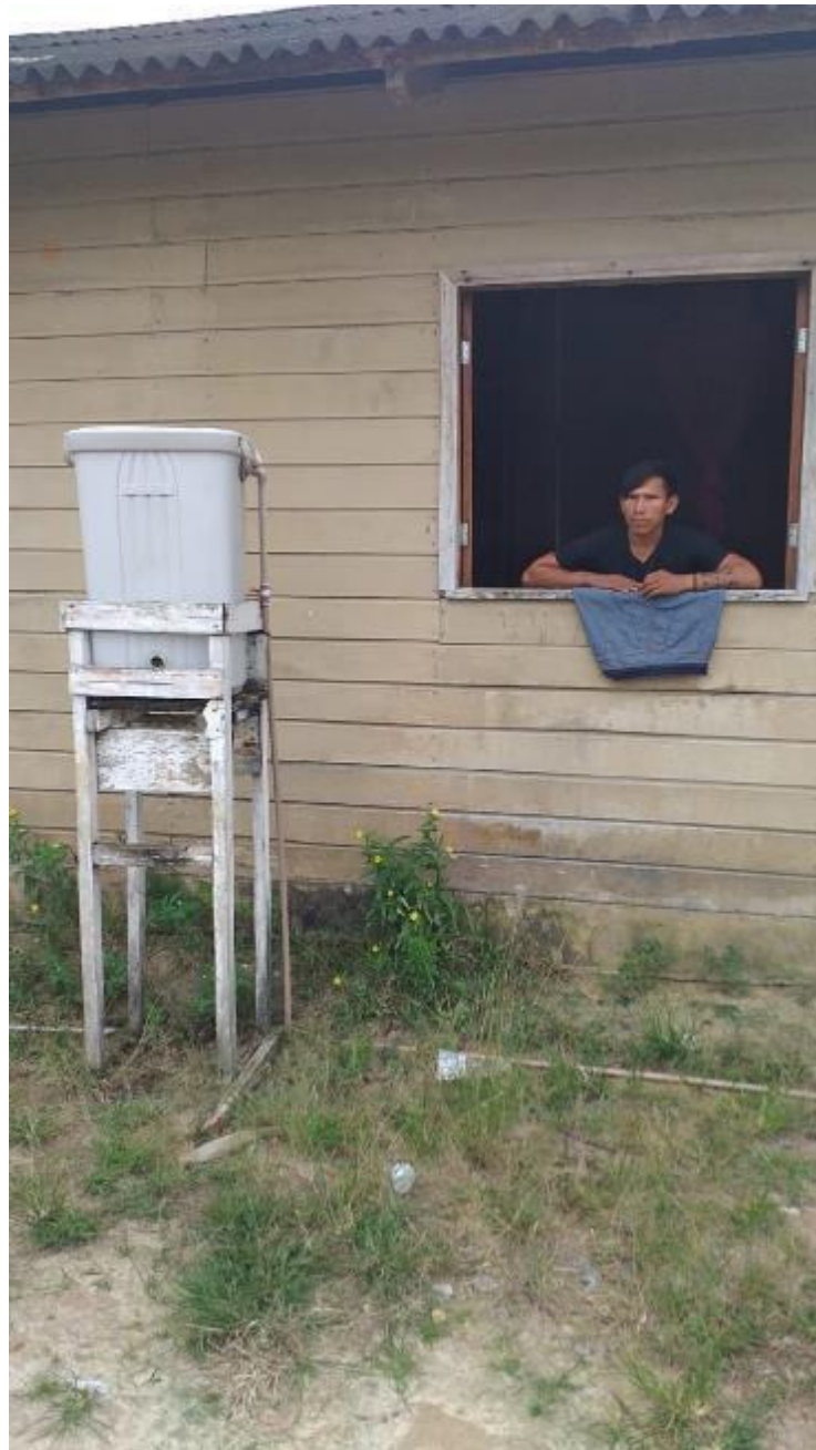
Fotografia 27. Equipamento para a cloração da água na aldeia Varinawa, existe em todas as aldeias da Terra Indígena Katukina/Campina. Fotografia: Leslye Ursini, 2022.
