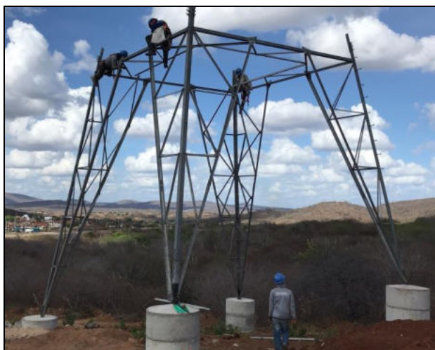
Figura 2 - Montagem de painéis inferiores
