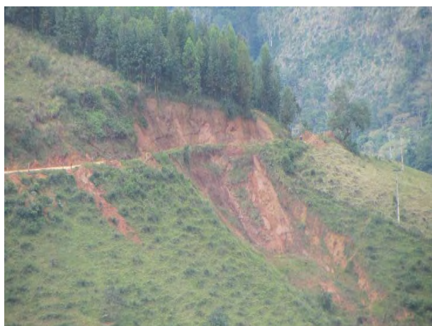
Figura 134. Feição de deslizamento em encosta.
