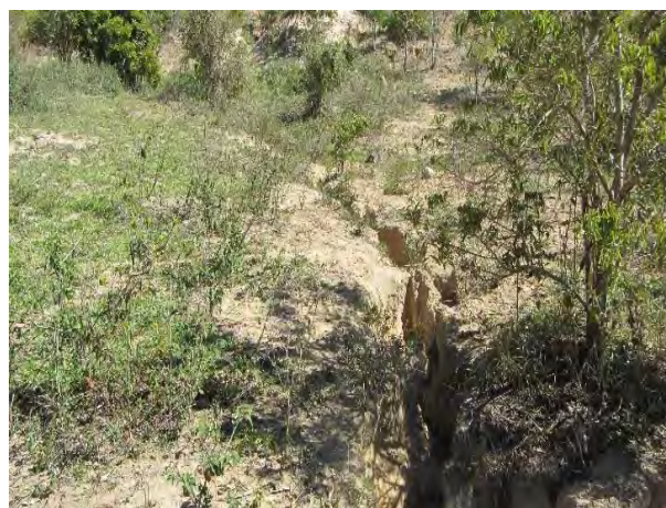
Figura 117. Sulco erosivo formado em encosta de baixa declividade.
