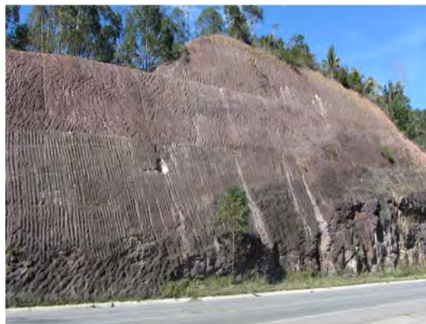
Figura 102. Corte de estrada evidenciando o comportamento da variação de profundidade da camada pedológica conforme se encontra o substrato rochoso. Notar que o solo é menos profundo no canto direito da fotografia, onde a rocha está exposta; e apresenta-se com mais de 10 metros no canto esquerdo (Coordenadas UTM DATUM SIRGAS 2000 Fuso 24S: 232472 E/8073990 N).
