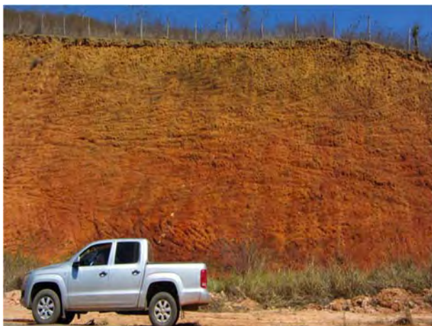
Figura 101. Corte de estrada em argissolo com profundidade superior a 6 metros. Notar que, na ausência de exposição do substrato rochoso, o solo apresenta-se com profundidade constante (Coordenadas UTM DATUM SIRGAS 2000 Fuso 24S: 213616 E/7974282 N).
