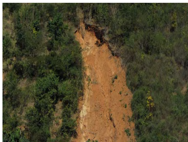
Figura 133. Feição de deslizamento com mobilização de solo e material vegetal.
