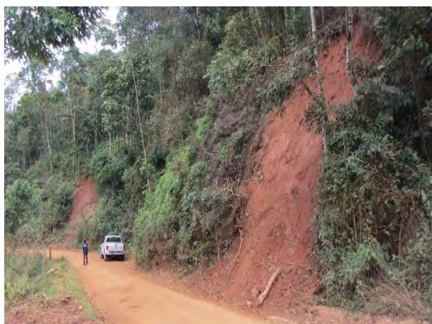
Figura 132. Feição de deslizamento com mobilização de solo e material vegetal. Notar árvores adernadas.
