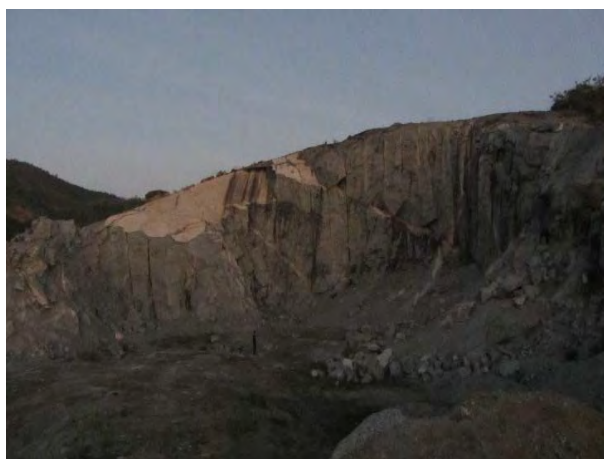
Figura 138. Queda de blocos em frente de lavra desativada.
