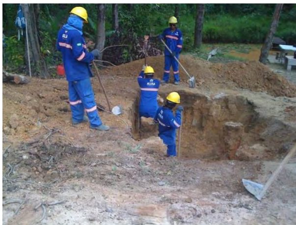
Figura 16. Exemplo de escavação para implantar uma fundação.
