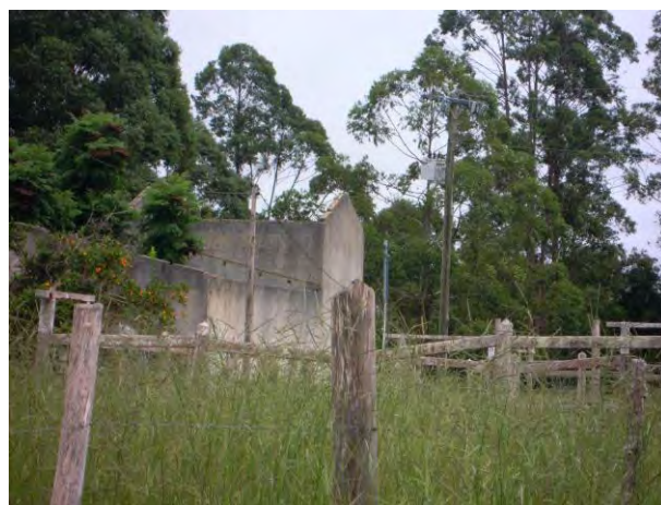
b) construções abandonadas
