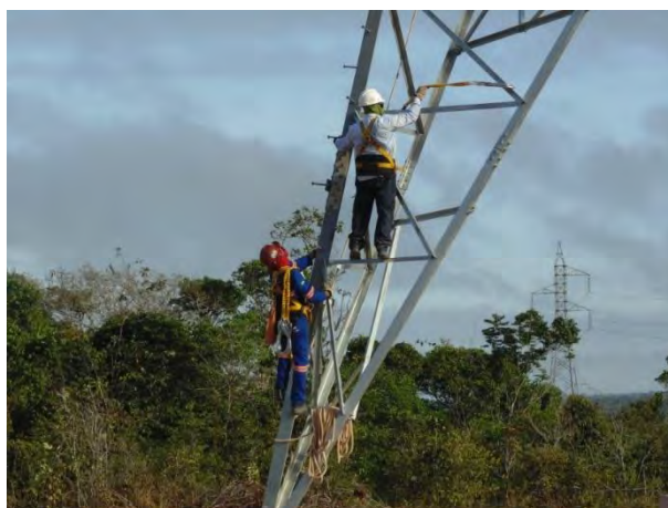
Figura 17. Colaboradores portando EPIs na execução da montagem das torres.
