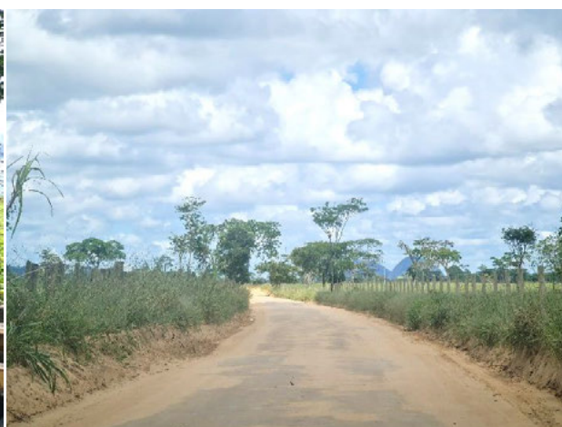
Foto 4-805: Vista da ES-313. Data: 15/03/21. Coordenadas UTM: 24K 362470E 7970437N. Azimute: 40°.
