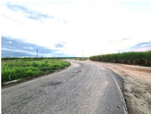
Foto 4-624: Vista da BA-290, na altura do trevo de acesso para a BA-693. Data: 17/03/21. Coordenadas UTM: 24K 373548E 8070557N. Azimute: 253°.
