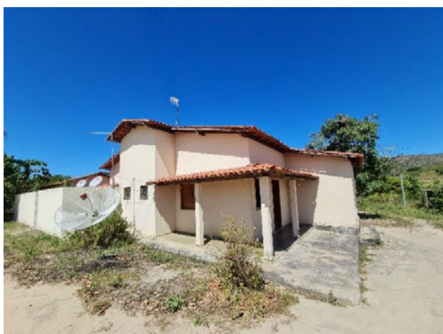
Foto 4-315: Residência de João Neves de Almeida. Data: 27/03/21. Coordenadas UTM: 24K 365034E 8205558N.
