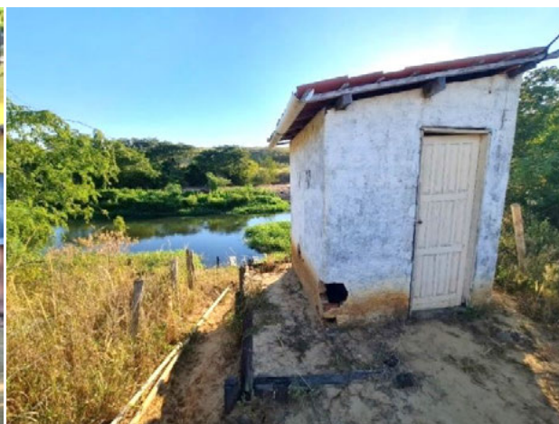
Foto 4-179: Captação de água no rio Pardo. Data: 30/03/21. Coordenadas UTM: 24L 356073E 8301229N.
