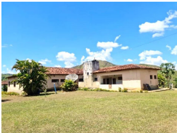
Foto 4-100: Sede da fazenda. Data: 01/04/21. Coordenadas UTM: 24L 349481E 8393795N.
