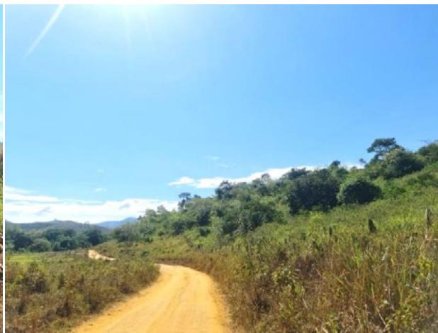
Foto 4-105: Acesso para o loteamento Catolé 1 e 2. Data: 01/04/21. Coordenadas UTM: 24L 351075E 8342975N. Azimute: 69°.
