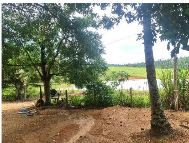
Foto 4-892: Vista do barramento do córrego da Serra. Data: 12/03/21. Coordenadas UTM: 24K 361011E 7918466N. Azimute: 110°.
