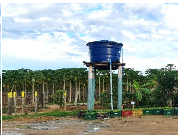
Foto 4-623: Sistema de armazenamento de água da cisterna. Data: 18/03/21. Coordenadas UTM: 24K 372660E 8071891N. Azimute: 240°.
