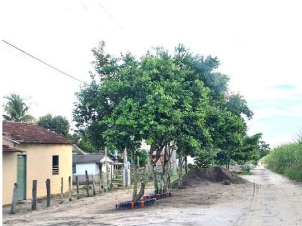
Foto 4-638: Vista geral da comunidade. Data: 18/03/21. Coordenadas UTM: 24K 375528E 8072053N.
