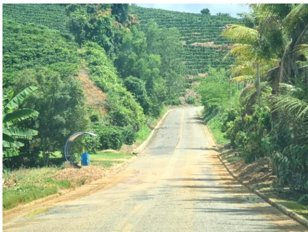
Foto 4-928: Vista da ES-245. Data: 11/03/21. Coordenadas UTM: 24K 357063E 7882641N. Azimute: 320°.
