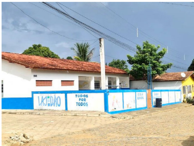
Foto 4-662: Vista da Escola Municipal Eugênia Viana Rodrigues. Data: 18/03/21. Coordenadas UTM: 24K 370977E 8053046N.
