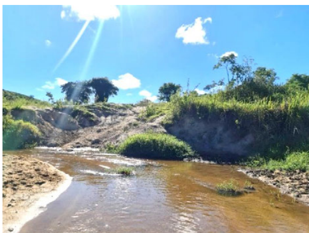
Foto 4-401: Passagem molhada sobre o córrego Santa Rosa no acesso para a Fazenda América. Data: 26/04/21. Coordenadas UTM: 24K 368862E 8161939N. Azimute: 270°.
