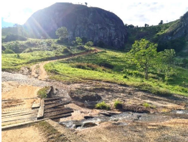
Foto 4-389: Ponte sobre o córrego Troncador na AEL. Data: 25/03/21. Coordenadas UTM: 24K 370462E 8154570N. Azimute 290°.
