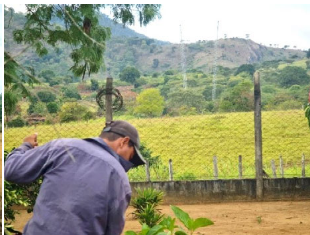
Foto 4-127: LT em construção ao fundo. Data: 01/04/21. Coordenadas UTM: 24L 352733E 8331224N. Azimute: 201°.
