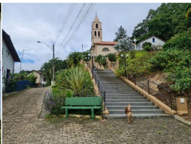
Foto 4-1045: Vista da igreja. Data: 09/03/21. Coordenadas UTM: 24K 351329E 7817198N.
