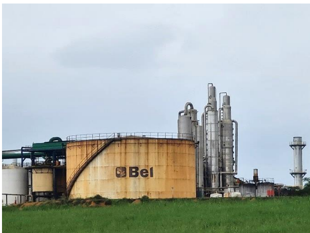
Foto 4-670: Vista da Usina Bahia Etanol na margem da BA-693. Data: 23/03/21. Coordenadas UTM: 24K 374465E 8048904N. Azimute: 15°.
