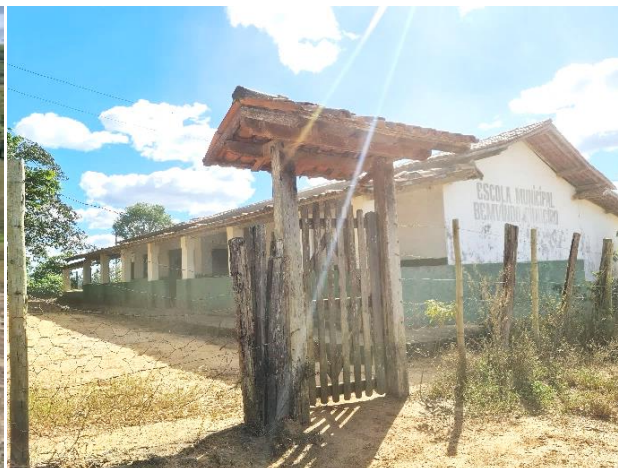
Foto 4-366: Escola Municipal da Vila. Data: 26/03/21. Coordenadas UTM: 24K 367604E 8175685N.
