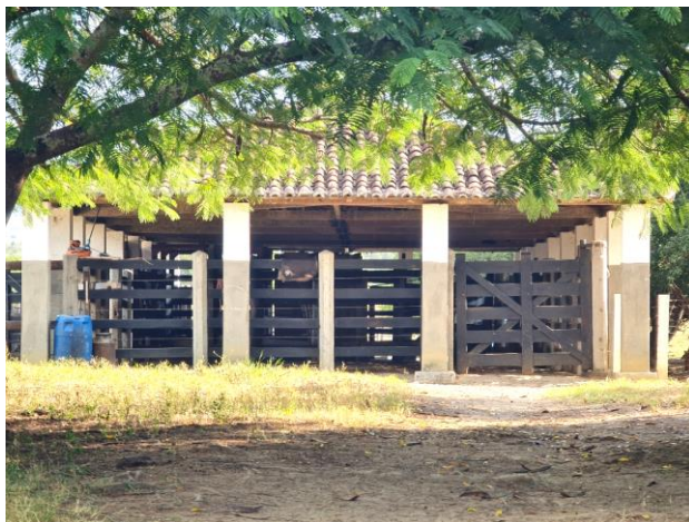
Foto 4-138: Curral da Fazenda Serra Verde. Data: 31/03/21. Coordenadas UTM: 24L 353575 E 8328663N. Azimute: 345°.
