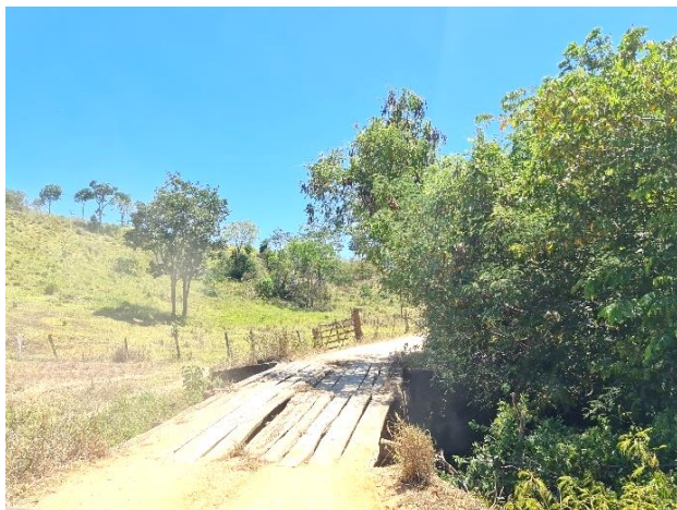
Foto 4-267: Ponte sobre o córrego Traíra. Data: 28/03/21. Coordenadas UTM: 24L 364566E 8235622N. Azimute: 8°.
