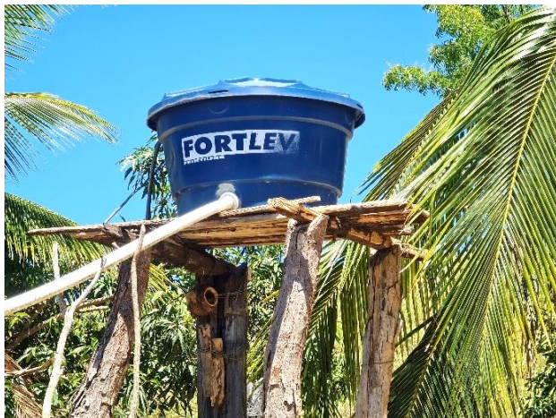
Foto 4-269: Sistema de armazenamento de água coletada da nascente. Data: 28/03/21. Coordenadas UTM: 24L 364523E 8235849N.
