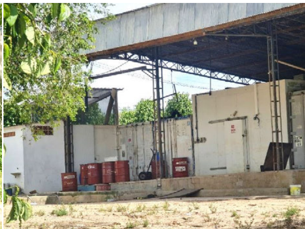
Foto 4-831: Vista do galpão de abrigo para os equipamentos. Data: 14/03/21. Coordenadas UTM: 24K 361164E 7953227N.
