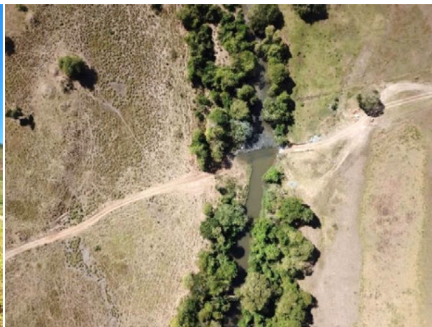
Foto 4-119: Passagem molhada no rio Catolé. Data: 01/04/21. Coordenadas UTM: 24L 352737E 8339578N.
