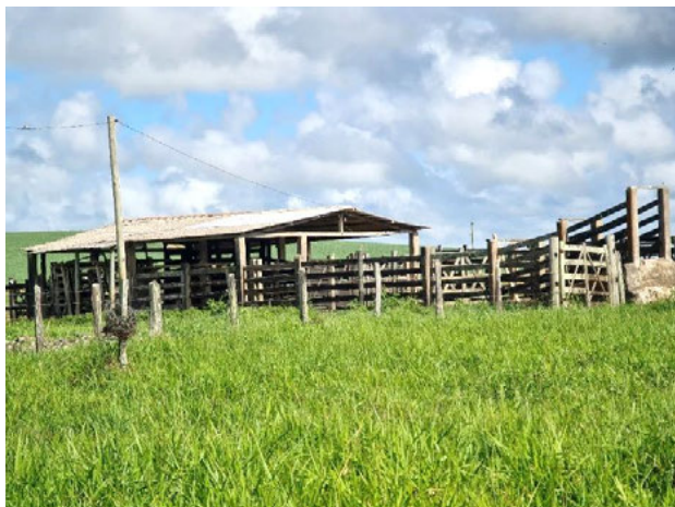
Foto 4-708: Vista do curral da propriedade. Data: 17/03/21. Coordenadas UTM: 24K 368182E 8024738N.
