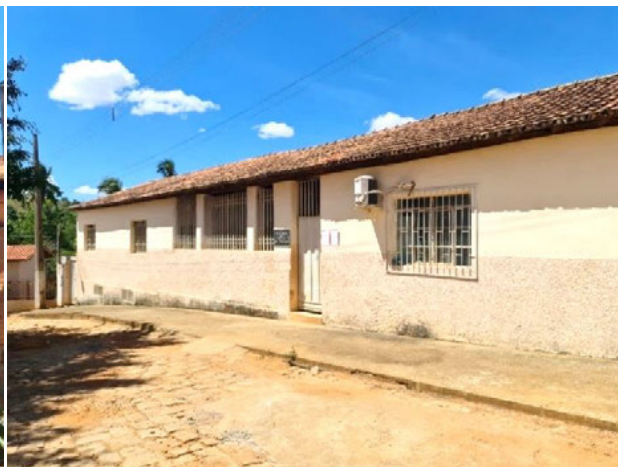
Foto 4-257: Vista da escola municipal. Data: 29/03/21. Coordenadas UTM: 24L 363297E 8246706N.
