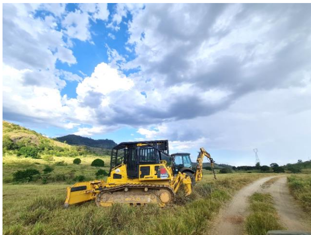
Foto 4-140: Maquinário da empresa construtora da LT. Data: 31/03/21. Coordenadas UTM: 24L 352656E 8329633N. Azimute: 168°.
