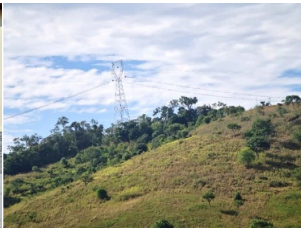
Foto 4-117: LT em construção na propriedade. Data: 01/04/21. Coordenadas UTM: 24L 352910E 8338600N. Azimute: 351°.
