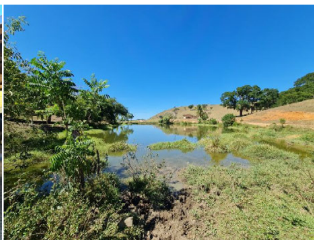
Foto 4-243: Barragem de curso d'água na fazenda. Data: 29/03/21. Coordenadas UTM: 24L 361845E 8258698N.
