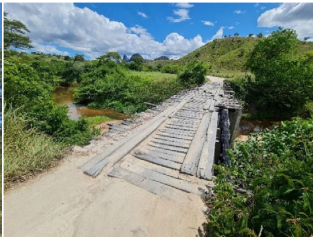
Foto 4-382: Ponte sobre o rio do Peixe na estrada de Buranhém para Monte Azul. Data: 25/03/21. Coordenadas UTM: 24K 378483E 8165957N. Azimute: 215°.
