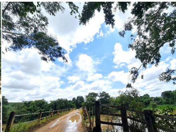
Foto 4-941: Visão da ponte sobre o rio São José na divisa com Vila Valério. Data: 11/03/21. Coordenadas UTM: 24K 359602E 7890000N. Azimute: 0°.
