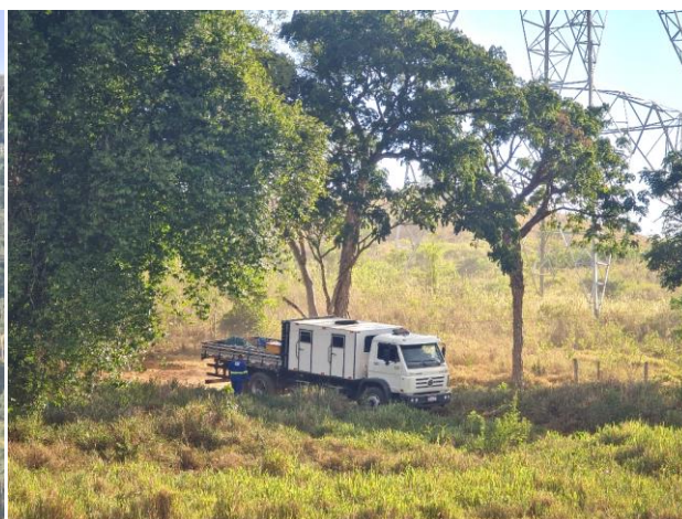
Foto 4-135: Empresa construtora trabalhando na construção da LT dentro da propriedade. Data: 31/03/21. Coordenadas UTM: 24L 353033E 8329142N.
