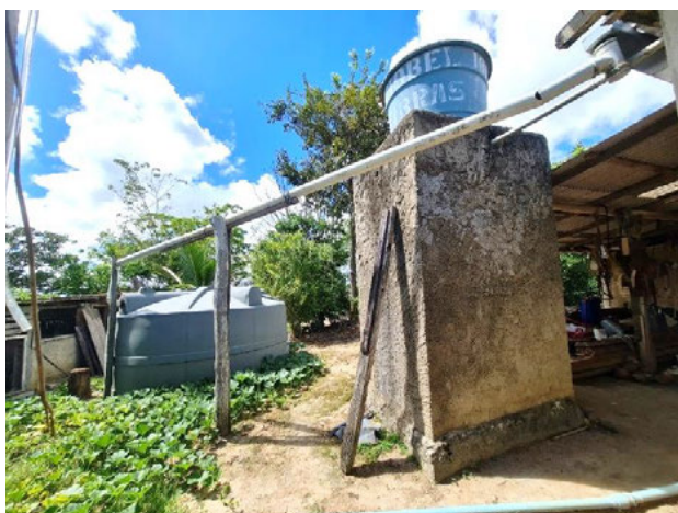
Foto 4-702: Sistema de captação e armazenamento de água da chuva e reservatório de água do poço artesiano. Data: 17/03/21. Coordenadas UTM: 24K 369256E 8028738N.
