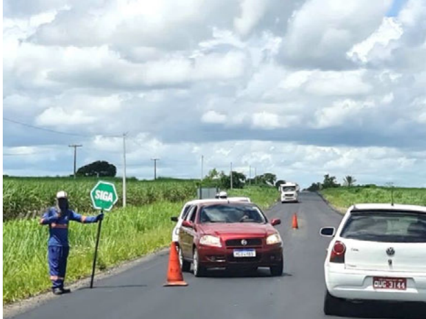
Foto 4-579: Vista da BA-290 em obras. Data: 23/03/21. Coordenadas UTM: 24K 371789E 8072360N. Azimute: 335°.
