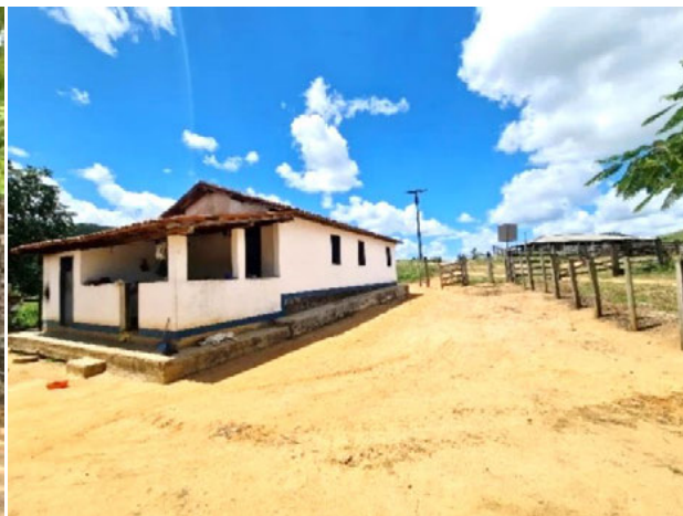
Foto 4-438: Residência de Nalzi Alves de Souza. Data: 24/03/21. Coordenadas UTM: 24K 372887E 8136637N.
