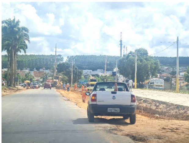
Foto 4-792: Vista da ES-130. Data: 16/03/21. Coordenadas UTM: 24K 371111E 7962594N. Azimute: 45°.
