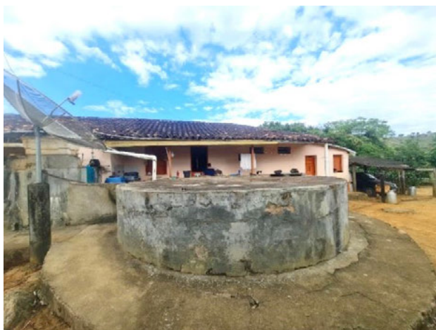
Foto 4-126: Sistema de coleta e armazenamento de água da chuva e antena parabólica. Data: 01/04/21. Coordenadas UTM: 24L 352733E 8331224N.
