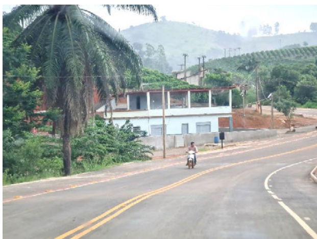
Foto 4-930: Estrada de Rio Bananal para o Panorama. Data: 10/03/21. Coordenadas UTM: 24K 358483E 7866417N. Azimute: 5°.
