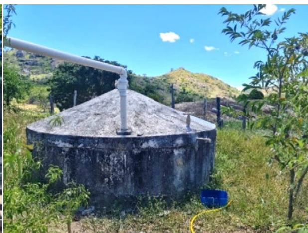
Foto 4-320: Armazenamento e coleta de água da chuva na propriedade. Data: 27/03/21. Coordenadas UTM: 24K 364665E 8201220N.
