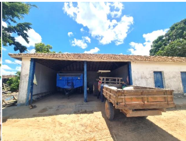
Foto 4-795: Vista do abrigo para os equipamentos. Data: 15/03/21. Coordenadas UTM: 24K 362639E 7974044N.
