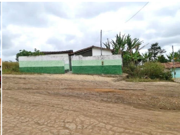
Foto 4-45: Escola José Francisco dos Santos. Data: 02/04/21. Coordenadas UTM: 24L 350505E 8372324N.
