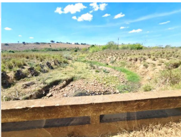
Foto 4-205: Ponte sobre o córrego Acaraí (seco) no acesso para a Fazenda Balada. Data: 30/03/21. Coordenadas UTM: 24L 359308E 8293859N. Azimute: 175°.
