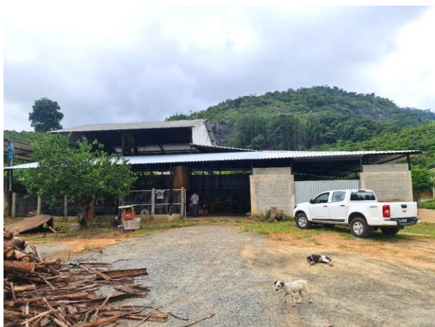
Foto 4-1064: Visão geral da propriedade. Data: 08/03/21. Coordenadas UTM: 24K 354374E 7813688N.
