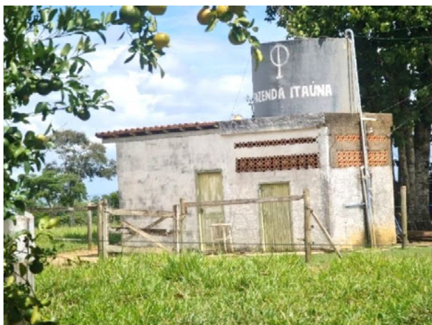
Foto 4-598: Sistema de captação e armazenamento de água da nascente. Data: 21/03/21. Coordenadas UTM: 24K 373416E 8082514N.
