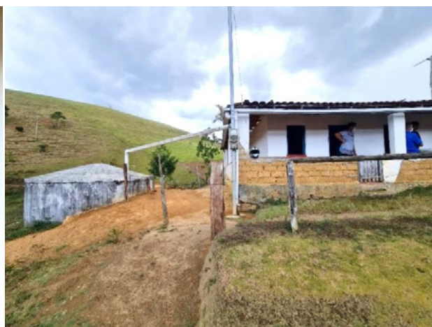
Foto 4-69: Sistema de coleta e armazenamento de água na propriedade. Data: 01/04/21. Coordenadas UTM: 24L 348928E 8357160N.
