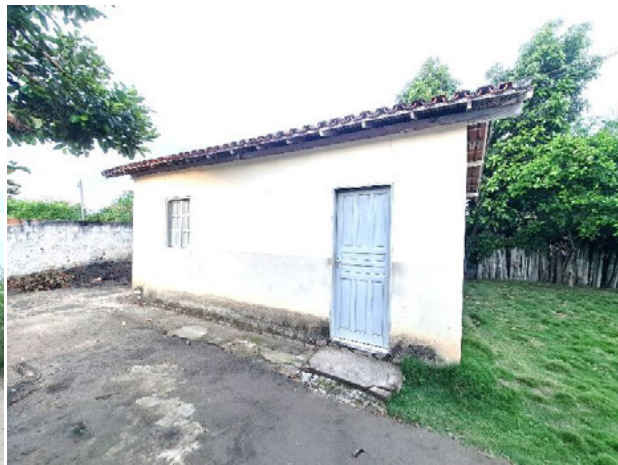
Foto 4-639: Vista do posto de saúde desativado. Data: 18/03/21. Coordenadas UTM: 24K 375528E 8072053N.
