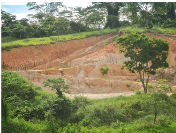
Foto 4-652: Extração de material para construção dos acessos. Data: 18/03/21. Coordenadas UTM: 24K 372549E 8057961N. Azimute: 350°.
