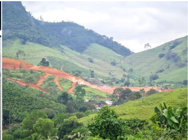
Foto 4-1055: Vista da construção da SE João Neiva 2. Data: 08/03/21. Coordenadas UTM: 24K 354231E 7814136N.
