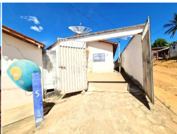
Foto 4-259: Vista de unidade de saúde. Data: 29/03/21. Coordenadas UTM: 24L 363297E 8246706N.
