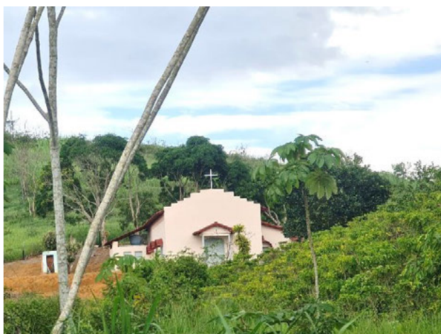
Foto 4-990: Vista da igreja. Data: 10/03/21. Coordenadas UTM: 24K 358956E 7862269N.
