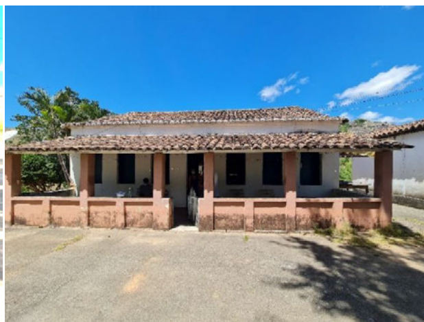
Foto 4-324: Residência do Juscelino Alves Souza. Data: 27/03/21. Coordenadas UTM: 24K 365287E 8198569N.
