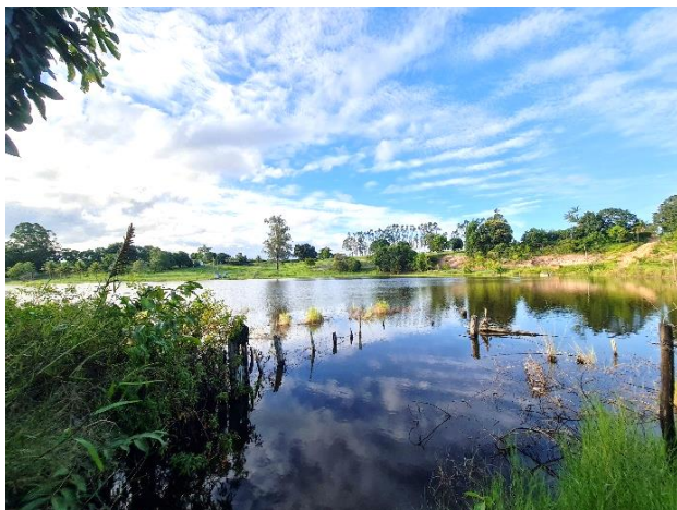
Foto 4-808: Vista do barramento do córrego São Domingos. Data: 14/03/21. Coordenadas UTM: 24K 363609E 7963954N. Azimute: 350°.
