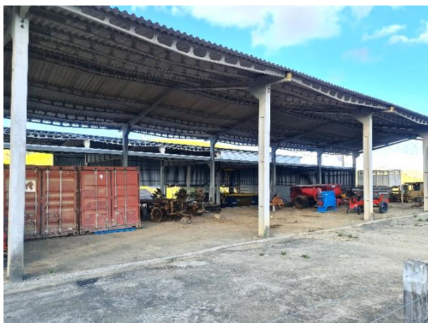
Foto 4-481: Garagem para o maquinário da fazenda. Data: 23/03/21. Coordenadas UTM: 24K 372266E 8119371N.
