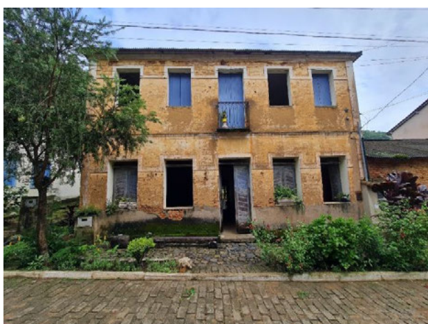
Foto 4-1040: Vista de construção do século XIX. Data: 09/03/21. Coordenadas UTM: 24K 351329E 7817198N.
