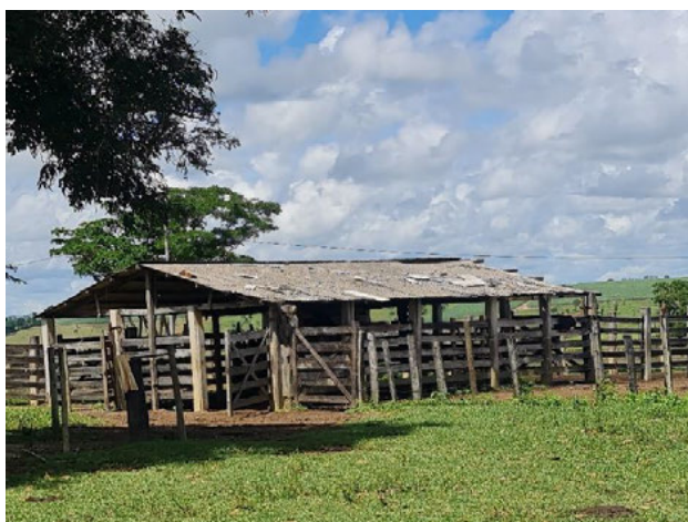
Foto 4-608: Vista do curral da propriedade. Data: 18/03/21. Coordenadas UTM: 24K 372907E 8075957N.
