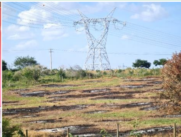
Foto 4-26: Sinais de queimada próxima à LT existente. Data: 02/04/21. Coordenadas UTM: 24L 349481E 8393795N.
