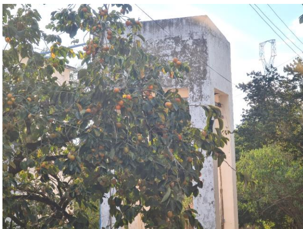
Foto 4-142: Reservatório de água. Data: 31/03/21. Coordenadas UTM: 24L 353575 E 8328663N.
