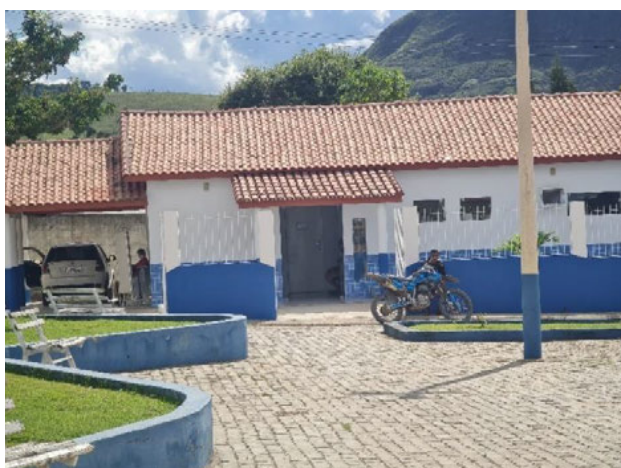
Foto 4-423: Unidade Básica de Saúde (UBS) no distrito de Monte Azul. Data: 25/03/21. Coordenadas UTM: 24K 371099E 8151967N.
