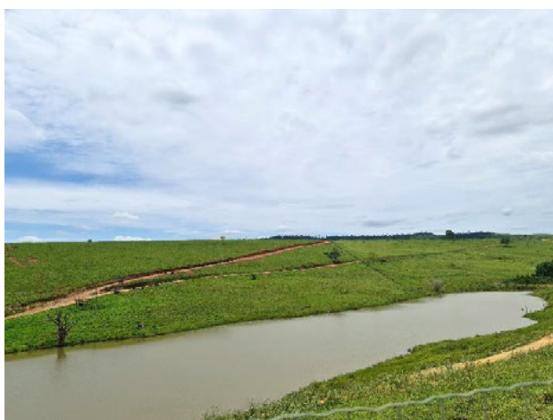
Foto 4-880: Vista do barramento do córrego do Meio. Data: 12/03/21. Coordenadas UTM: 24K 361315E 7924573N. Azimute: 140°.
