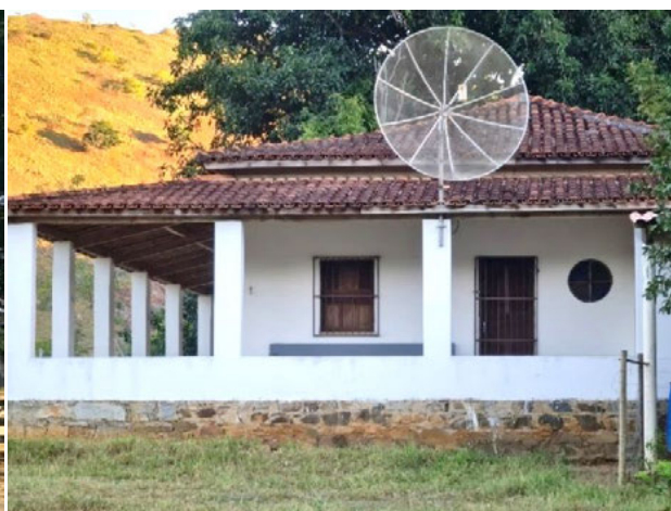
Foto 4-237: Sede da fazenda. Data: 29/03/21. Coordenadas UTM: 24L 360597E 8264170N.
