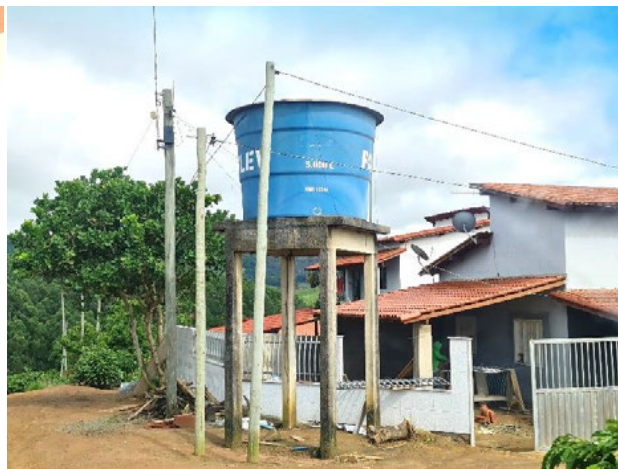
Foto 4-969: Vista do armazenamento de água do poço artesiano. Data: 11/03/21. Coordenadas UTM: 24K 357642E 7876972N.
