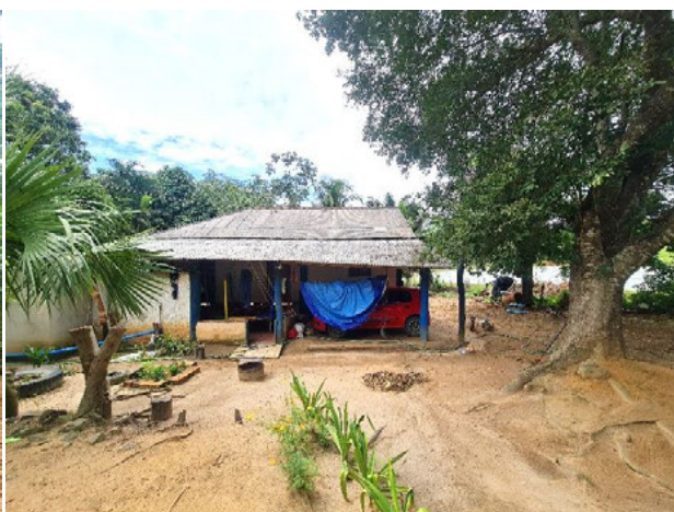
Foto 4-891: Visão geral da propriedade. Data: 12/03/21. Coordenadas UTM: 24K 361011E 7918466N.
