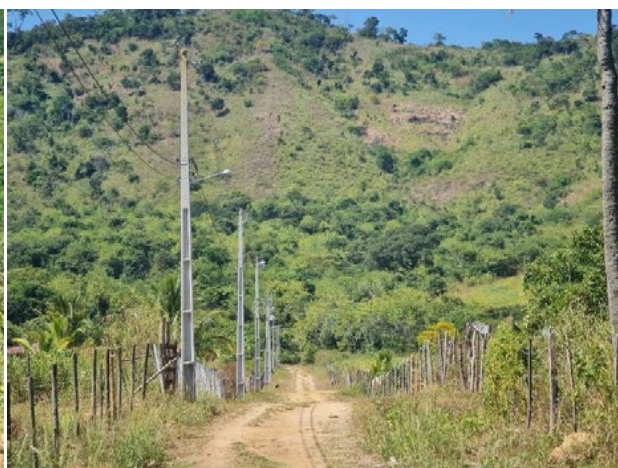
Foto 4-113: Visão geral da rua com iluminação pública. Data: 01/04/21. Coordenadas UTM: 24L 351501E 8343731N.
