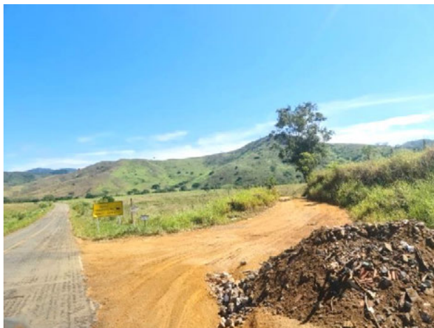
Foto 4-104: Acesso pela BA-646. Data: 01/04/21. Coordenadas UTM: 24L 350286E 8342364N. Azimute: 152°.
