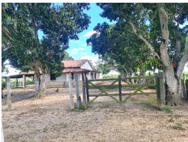
Foto 4-718: Vista da residência de José Vieira dos Santos. Data: 16/03/21. Coordenadas UTM: 24K 368889E 8019554N.
