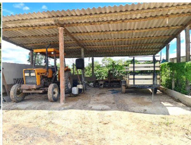
Foto 4-801: Vista do abrigo para os equipamentos. Data: 15/03/21. Coordenadas UTM: 24K 363486E 7970274N.
