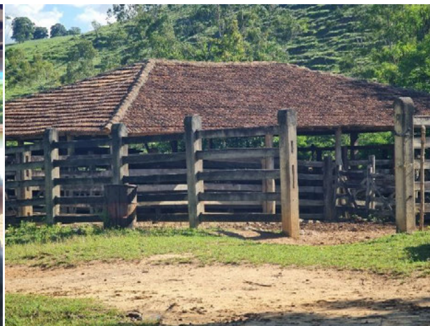
Foto 4-583: Vista do curral da propriedade. Data: 21/03/21. Coordenadas UTM: 24K 372550E 8091881N.
