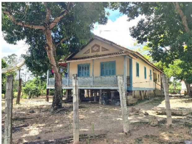
Foto 4-940: Casa suspensa para proteção contra enchente. Data: 11/03/21. Coordenadas UTM: 24K 3 359541E 7889823N.
