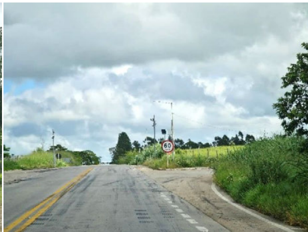
Foto 4-685: Vista da BR-418, na altura do trevo de acesso para a MG-71. Data: 17/03/21. Coordenadas UTM: 24K 365826E 8028838N. Azimute: 338°.
