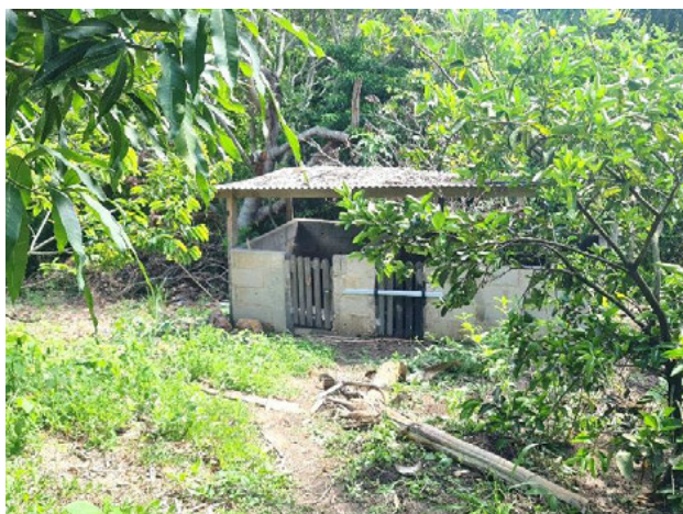
Foto 4-764: Vista do chiqueiro. Data: 16/03/21. Coordenadas UTM: 24K 366262E 8002289N.
