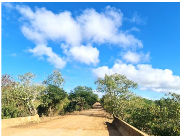
Foto 4-218: Vista da BA-130. Data: 29/03/21. Coodenadas UTM: 24L 364326E 8273274N. Azimute: 300°.
