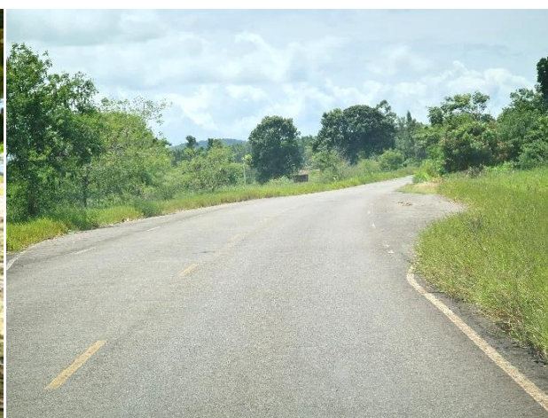
Foto 4-593: Vista do acesso para a propriedade na BA-690. Data: 21/03/21. Coordenadas UTM: 24K 375116E 8083129N. Azimute: 15°.
