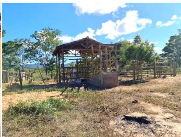
Foto 4-302: Vista do curral da propriedade. Data: 28/03/21. Coordenadas UTM: 24K 365374E 8214159N.
