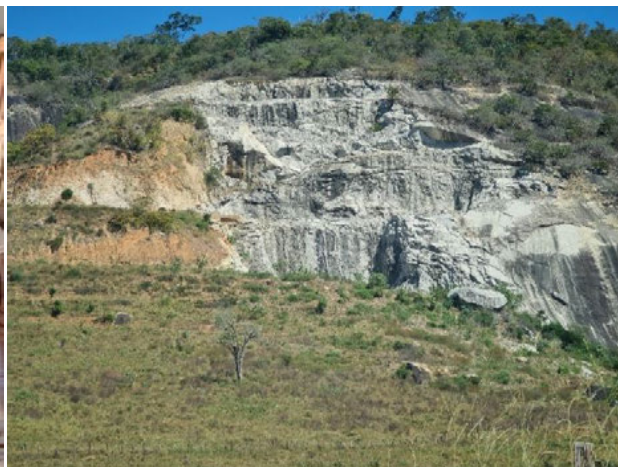
Foto 4-312: Extração de rocha para produção de brita durante a pavimentação da MG-405. Data: 27/03/21. Coordenadas UTM: 24K 365035E 8204941N. Azimute: 180°.
