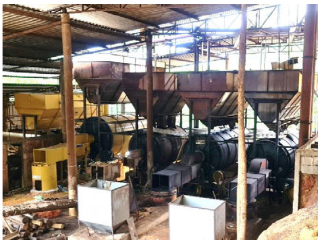
Foto 4-920: Vista dos secadores de café. Data: 11/03/21. Coordenadas UTM: 24K 360722E 7906781N.
