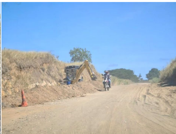
Foto 4-191: BA-130 em obras na AEL. Data: 30/03/21. Coordenadas UTM: 24L 360004E 8277761N. Azimute: 295°.
