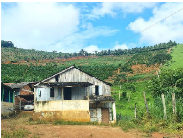
Foto 4-980: Vista das residências do loteamento. Data: 11/03/21. Coordenadas UTM: 24K 358708E 7871977N.
