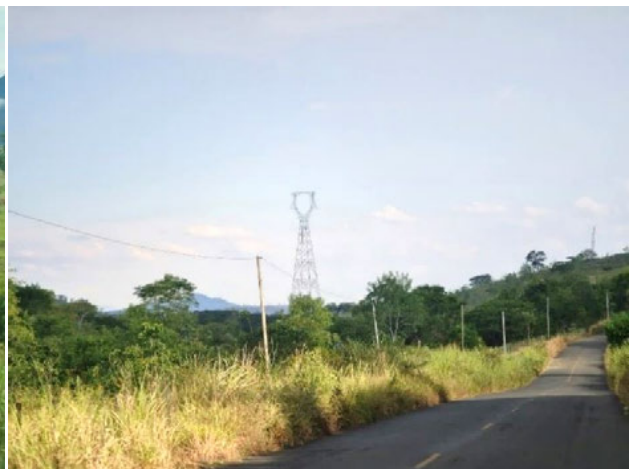
Foto 4-131: Vista da LT existente paralela à BA-646. Data: 31/03/21. Coordenadas UTM: 24L 352452E 8330166N. Azimute: 328°.
