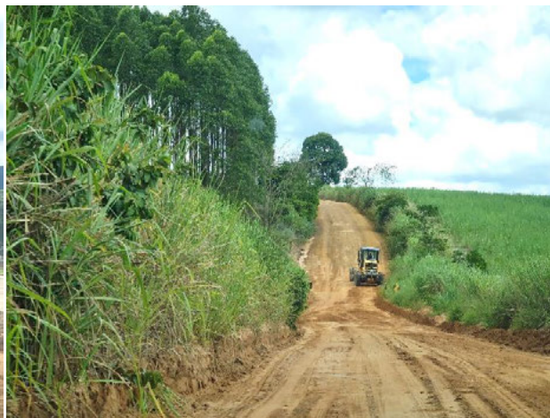
Foto 4-793: Vista da ES-313. Data: 15/03/21. Coordenadas UTM: 24K 364452E 7969793N. Azimute: 295°.
