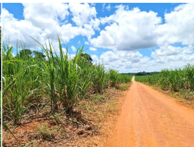
Foto 4-799: Vista da ES-313. Data: 15/03/21. Coordenadas UTM: 24K 359001E 7971820N. Azimute: 65°.
