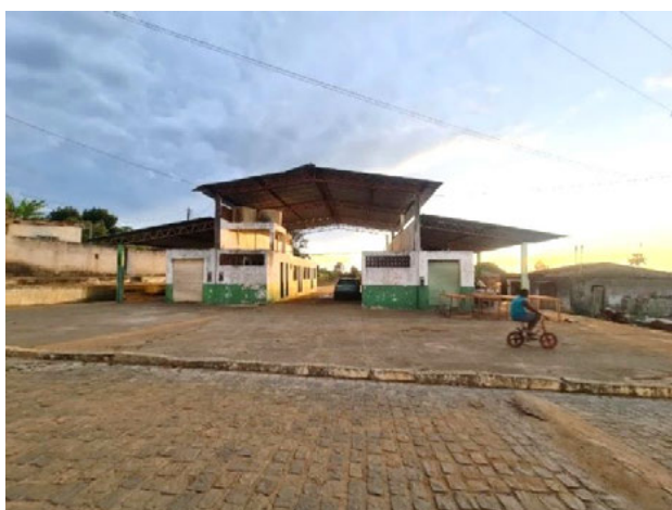
Foto 4-60: Central de abastecimento. Data: 01/04/21. Coordenadas UTM: 24L 347628E 8364563N.
