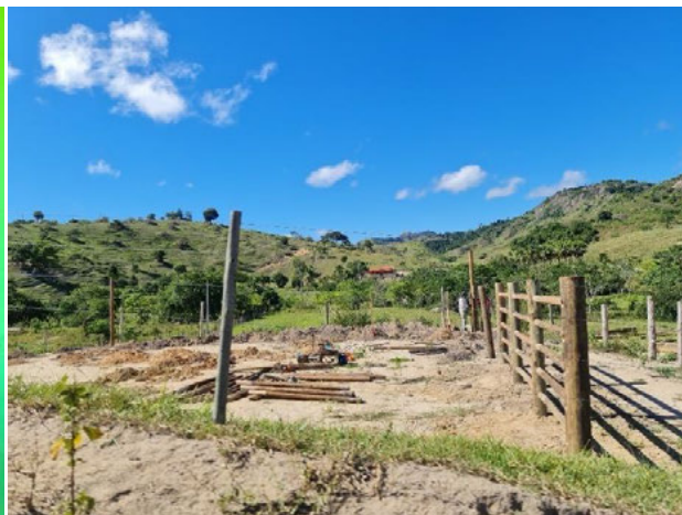
Foto 4-398: Curral em construção na comunidade. Data: 26/03/21. Coordenadas UTM: 24K 368248E 8161767N.
