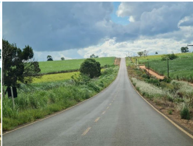
Foto 4-647: Vista da BA-693 na AEL. Data: 21/03/21. Coordenadas UTM: 24K 370731E 8051331N. Azimute: 155°.
