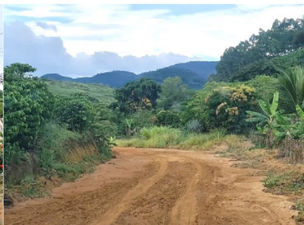
Foto 4-993: Visão geral da estrada para a comunidade. Data: 11/03/21. Coordenadas UTM: 24K 359213E 7862883N. Azimute: 198°.
