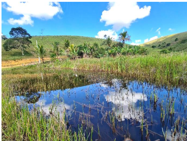
Foto 4-491: Barramento do córrego da Malaia. Data: 23/03/21. Coordenadas UTM: 24K 371509E 8114936N.
