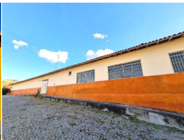
Foto 4-278: Escola estadual no distrito de Jaguarão. Data: 26/03/21. Coordenadas UTM: 24K 366164E 8187615N.
