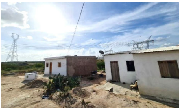
Foto 4-23: Vista do loteamento com a SE Poções III ao fundo. Data: 02/04/21. Coordenadas UTM: 24L 349498E 8393797N.
