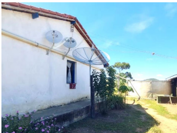
Foto 4-210: Detalhe das antenas de TV a cabo e internet. Data: 30/03/21. Coordenadas UTM: 24L 58982E 8283739N.
