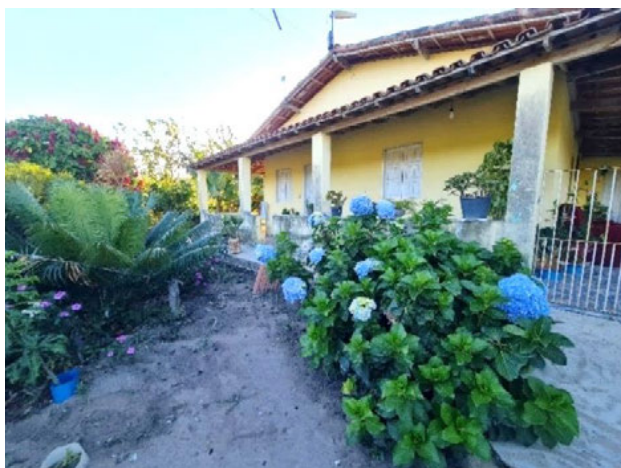
Foto 4-465: Residência de Noel Francisco Vagis. Data: 23/03/21. Coordenadas UTM: 24K 371085E 8121691N.
