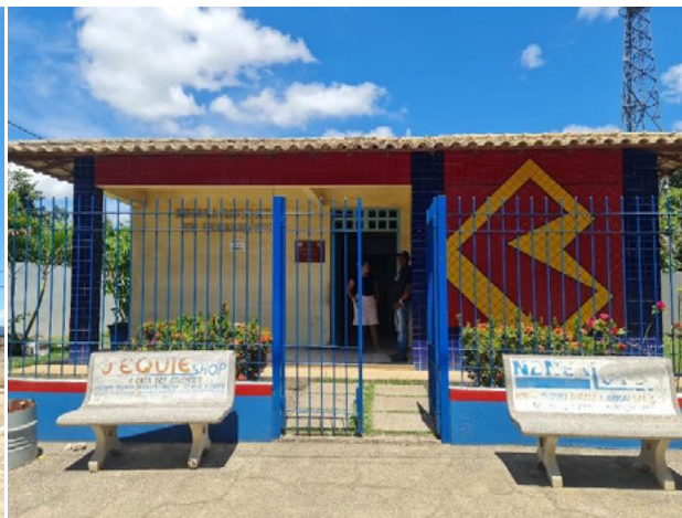
Foto 4-733: Vista da Escola Municipal de Informática. Data: 16/03/21. Coordenadas UTM: 24K 368851E 8015759N.
