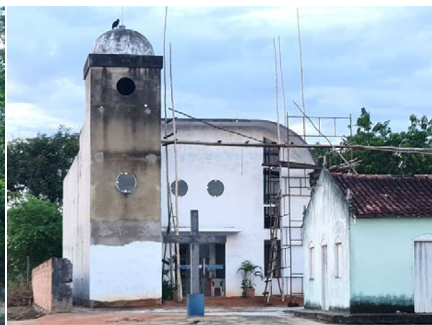
Foto 4-633: Visão da reforma da igreja católica. Data: 18/03/21. Coordenadas UTM: 24K 375528E 8072053N.
