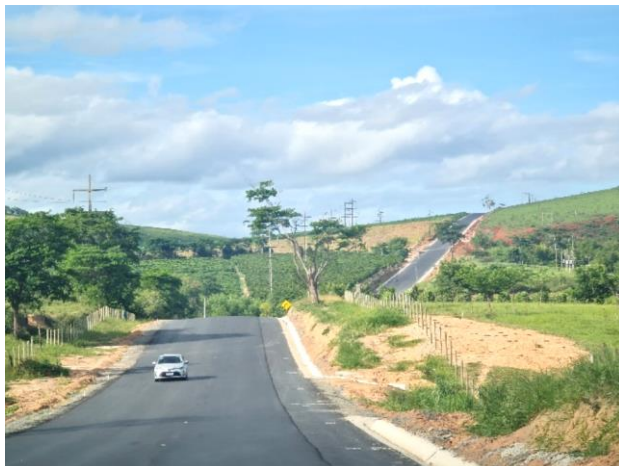
Foto 4-790: Vista da ES-130. Data: 15/03/21. Coordenadas UTM: 24K 367178E 7959553N. Azimute: 15°.
