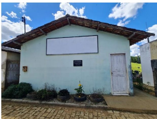
Foto 4-509: Unidade Básica de Saúde (UBS) distrito de Monte Azul. Data: 23/03/21. Coordenadas UTM: 24K 374793E 8110621N.
