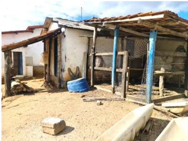
Foto 4-433: Vista do galinheiro da propriedade. Data: 25/03/21. Coordenadas UTM: 24K 370343E 8150257N.
