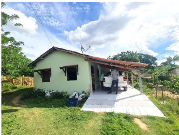
Foto 4-824: Vista da residência de Antônio Carmo de Azevedo. Data: 14/03/21. Coordenadas UTM: 24K 360980E 7955191N.
