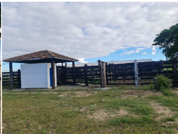
Foto 4-779: Vista do curral da propriedade. Data: 15/03/21. Coordenadas UTM: 24K 365688E 7991944N.
