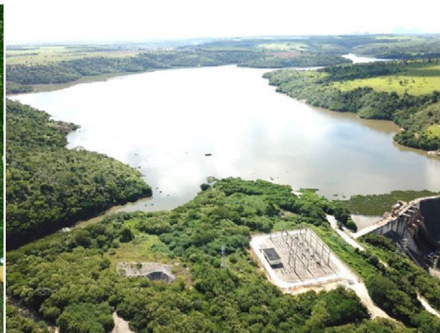
Foto 4-715: Vista do reservatório da UHE Santa Clara. Data: 16/03/21. Coordenadas UTM: 24K 371507E 8021004N. Azimute: 315°.
