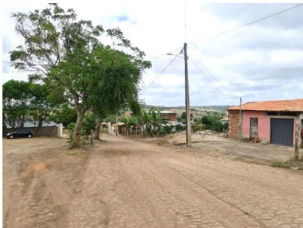
Foto 4-44: Avenida principal com iluminação pública. Data: 02/04/21. Coordenadas UTM: 24L 350505E 8372324N.
