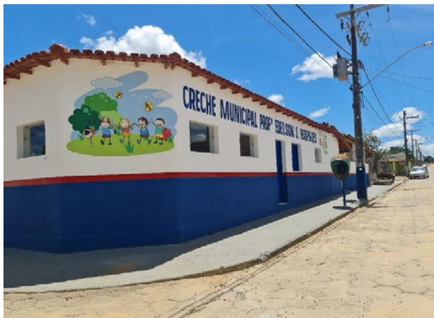
Foto 4-726: Vista da creche municipal. Data: 16/03/21. Coordenadas UTM: 24K 368851E 8015759N.
