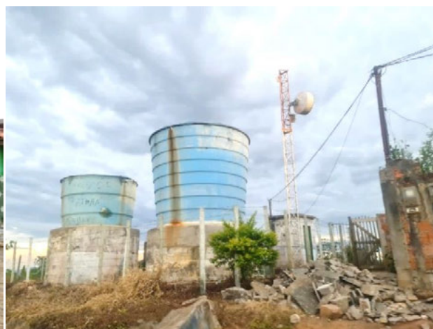
Foto 4-59: Sistema de abastecimento de água e antena. Data: 01/04/21. Coordenadas UTM: 24L 347805E 8364195N.
