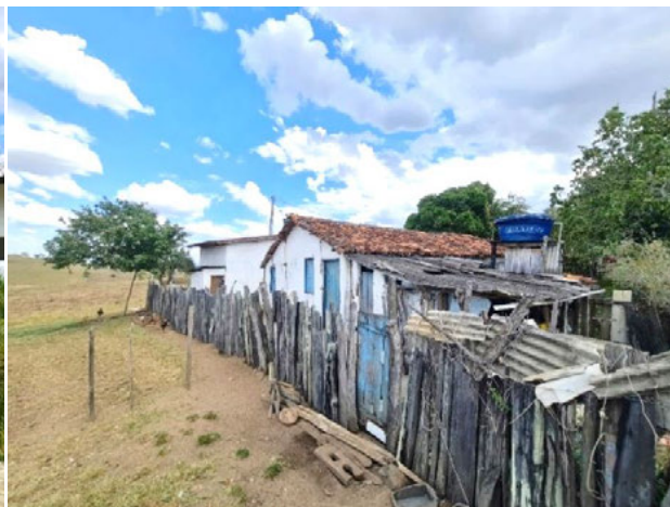
Foto 4-159: Residências dos funcionários. Data: 31/03/21. Coordenadas UTM: 24L 356096E 8318126N.
