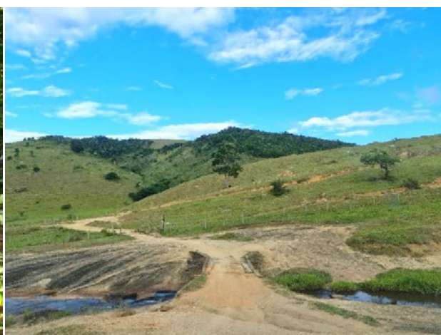
Foto 4-414: Ponte sobre o córrego Troncador no acesso à propriedade. Data: 25/03/21. Coordenadas UTM: 24K 370462E 8154570N. Azimute: 90°.
