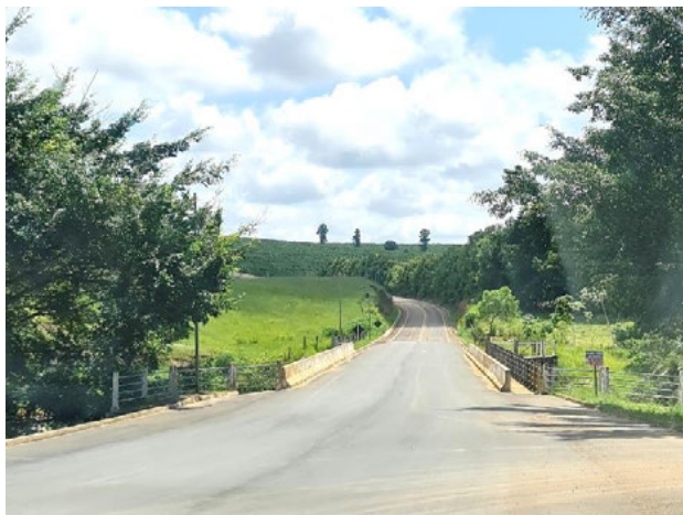
Foto 4-938: Vista da ponte sobre rio São José na ES-432. Data: 11/03/21. Coordenadas UTM: 24K 360347E 7909561N. Azimute: 290°.
