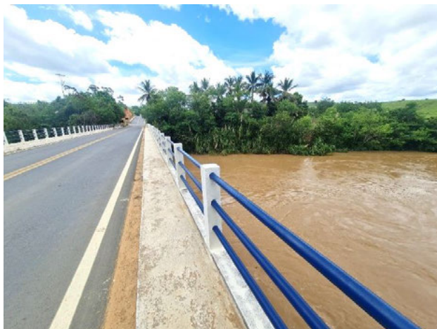
Foto 4-818: Vista da ponte sobre o rio do Norte na divisa com Nova Venécia, na ES-130. Data: 14/03/21. Coordenadas UTM: 24K 365255E 7945838N. Azimute: 355°.
