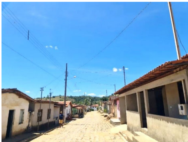
Foto 4-252: Avenida principal com iluminação pública. Data: 29/03/21. Coordenadas UTM: 24L 363084E 8246648N.
