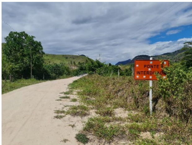
Foto 4-383: Ponte sobre o rio do Peixe interditada na estrada de Buranhém para Monte Azul. Data: 25/03/21. Coordenadas UTM: 24K 378483E 8165957N. Azimute: 120°.
