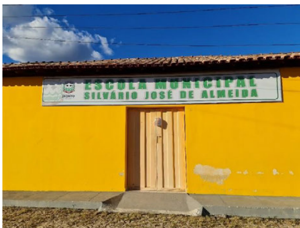
Foto 4-277: Escola Municipal Silvário José de Almeida, no distrito de Jaguarão. Data: 26/03/21. Coordenadas UTM: 24K 366164E 8187615N.
