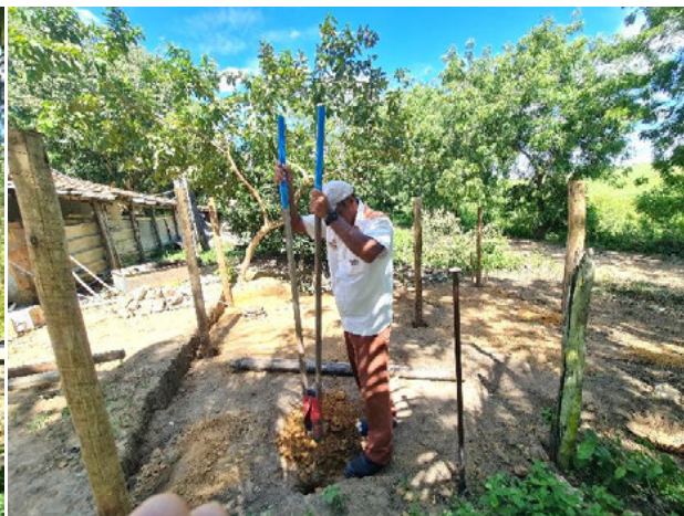
Foto 4-739: Execução da obra de mudança do chiqueiro de lugar devido ao furto constante de porcos na fazenda. Data: 16/03/21. Coordenadas UTM: 24K 367097E 8015849N.
