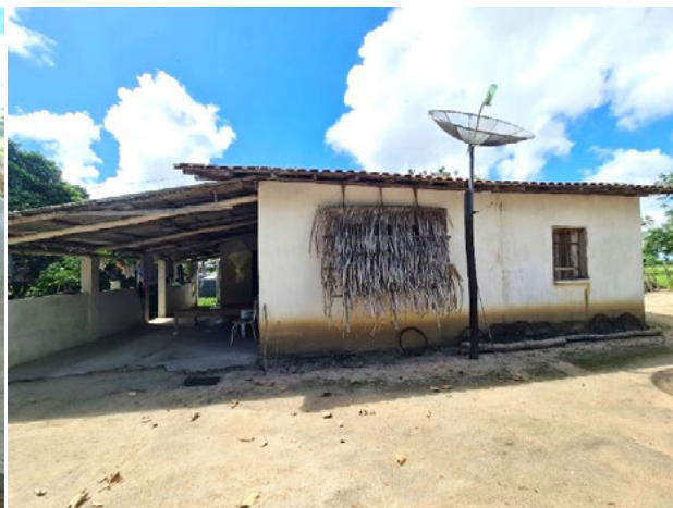
Foto 4-701: Vista da residência de Marinalva da Cruz de Freitas. Data: 17/03/21. Coordenadas UTM: 24K 369256E 8028738N.
