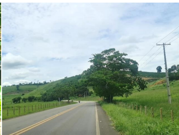
Foto 4-875: Vista da BR-381 próxima à Escadinha. Data: 12/03/21. Coordenadas UTM: 24K 361674E 7929815N. Azimute: 160°.
