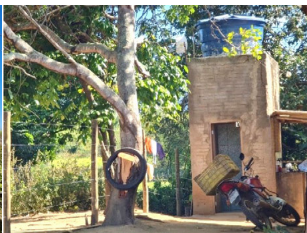
Foto 4-304: Armazenamento da água coletada do rio Jequitinhonha. Data: 28/03/21. Coordenadas UTM: 24K 365374E 8214159N.
