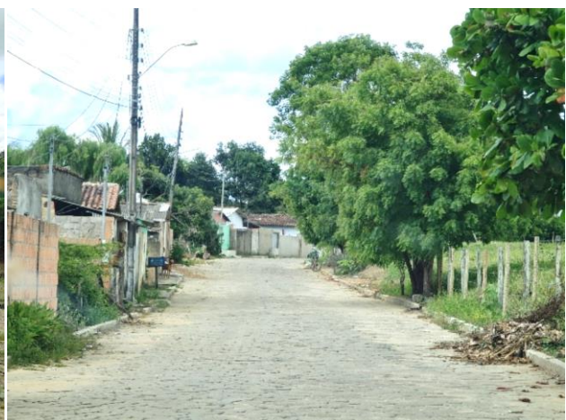
Foto 4-693: Vista da Avenida Contorno Amazonas. Data: 17/03/21. Coordenadas UTM: 24K 369445E 8032554N. Azimute: 34°.
