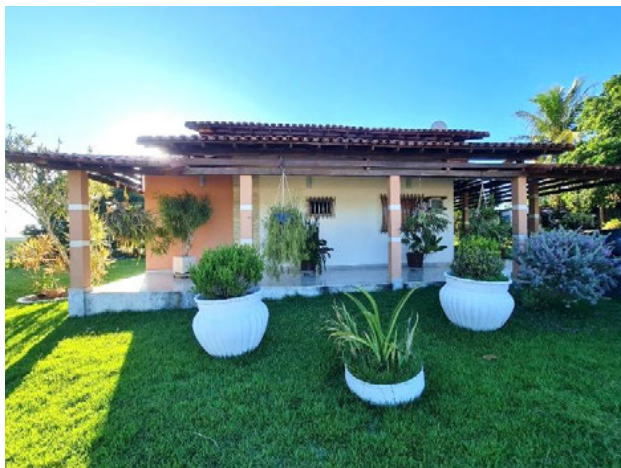
Foto 4-768: Vista do padrão construtivo do local. Data: 15/03/21. Coordenadas UTM: 24K 365183E 7994067N.
