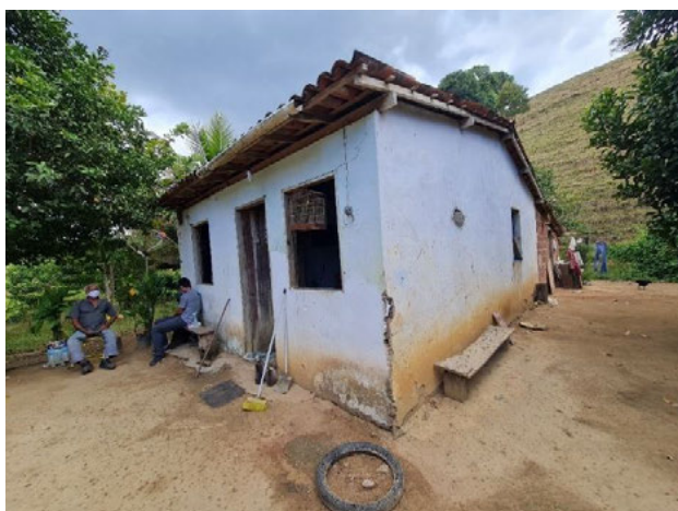
Foto 4-84: Residência de Augusto Santana. Data: 01/04/21. Coordenadas UTM: 24L 349484E 8354178N.
