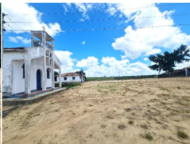
Foto 4-797: Visão geral da igreja e da sede da fazenda. Data: 15/03/21. Coordenadas UTM; 24K 362639E 7974044N.
