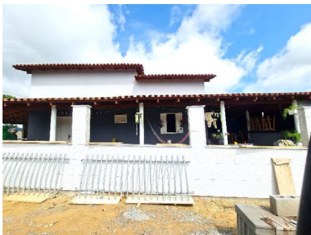
Foto 4-972: Vista da residência de Terezinha Maurício Abraão. Data: 11/03/21. Coordenadas UTM: 24K 357642E 7876972N.
