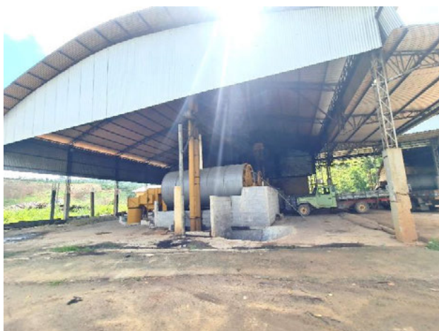
Foto 4-964: Vista do secador de café da comunidade. Data: 11/03/21. Coordenadas UTM: 24K 358928E 7879406N.
