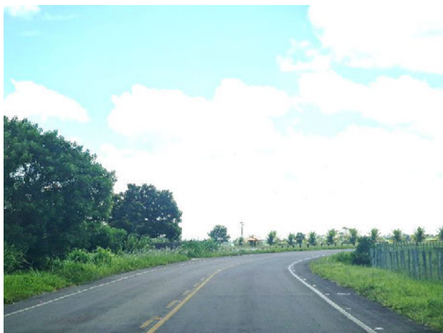
Foto 4-746: Vista da ES-209. Data: 16/03/21. Coordenadas UTM: 24K 364586E 7999912N. Azimute: 28°.
