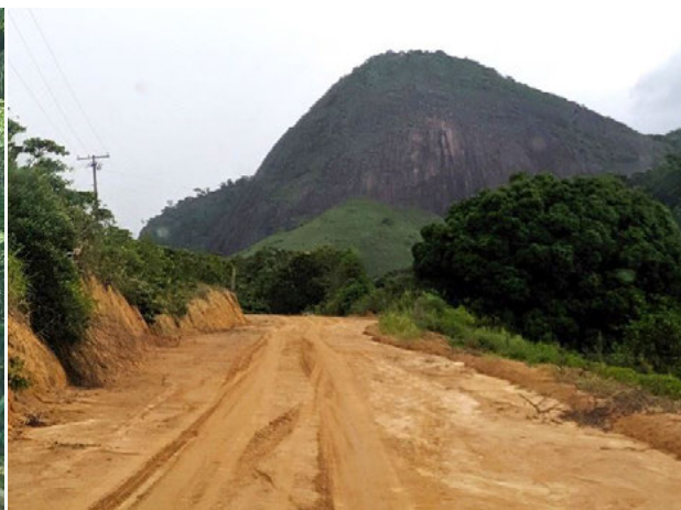
Foto 4-929: Vista da estrada para o Panorama. Data: 11/03/21. Coordenadas UTM: 24K 357936E 7862620N. Azimute: 298°.
