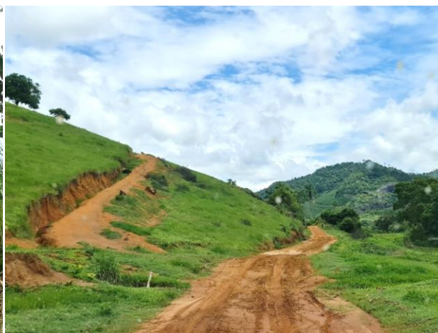
Foto 4-1003: Vista da estrada para o Panorama. Data: 10/03/21. Coordenadas UTM: 24K 361614E 7856530N. Azimute: 280°.
