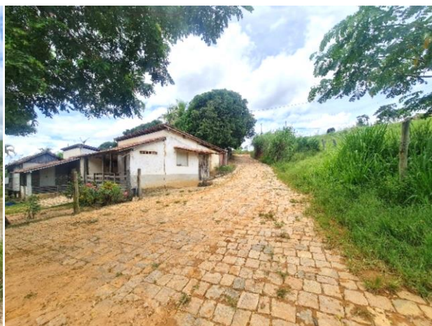
Foto 4-847: Vista da estrada da propriedade. Data: 14/03/21. Coordenadas UTM: 24K 361151E 7945555N. Azimute: 180°.
