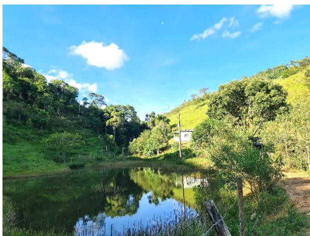
Foto 4-523: Vista do barramento do córrego João Ferrira. Data: 22/03/21. Coordenadas UTM: 24K 372010E 8107528N.
