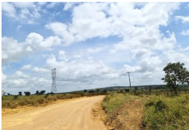
Foto 4-37: Acesso (BA-642) para o distrito de Parafuso. Data: 02/04/21. Coordenadas UTM: 24L 344780E 8374532N. Azimute: 330°.
