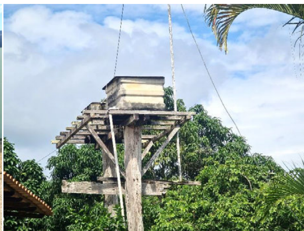
Foto 4-963: Armazenamento de água na comunidade. Data: 11/03/21. Coordenadas UTM: 24K 358928E 7879406N.
