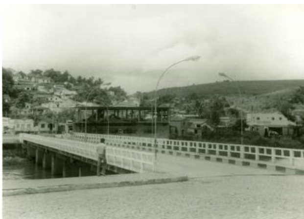
Foto 4-49: Ponte sobre o Rio Itanhém, Bahia. Fonte: IBGE [19-].
