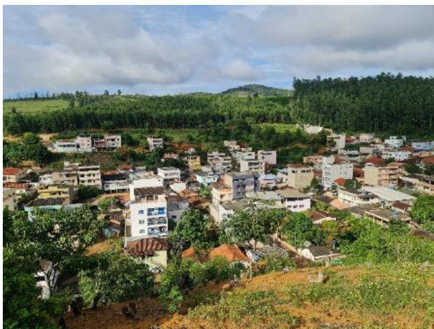
Foto 4-105: Visão geral da cidade. Marilândia, Espírito Santo. Coordenadas: -19° 24' 38,44", -40° 32' 36,08". Data: 09/03/2021.
