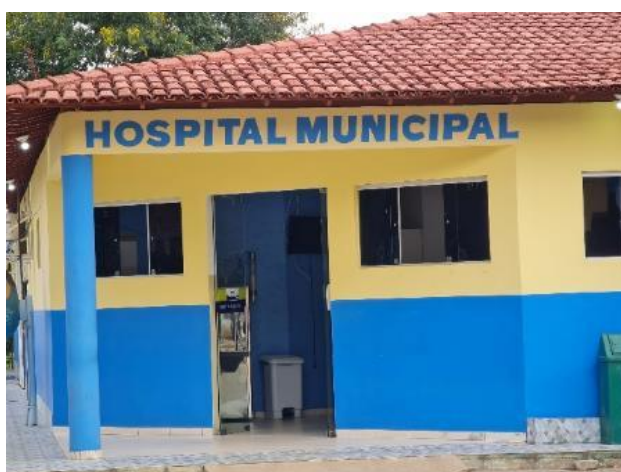
Foto 4-145: Hospital Municipal de Jucuruçu. Data: 24/03/2021. Coordenadas: -16° 50' 25,39", -40° 9' 19,29".
