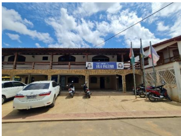
Foto 4-127: Prefeitura Municipal. Vila Valério, Espírito Santo. Coordenadas: -19° 0' 2,6", -40° 23' 25,68". Data: 11/03/2021.
