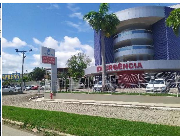
Foto 4-148: Hospital São Bernardo. Colatina. Data: 07/03/2021. Coordenadas: -19° 31' 3,86", -40° 36' 22,51".
