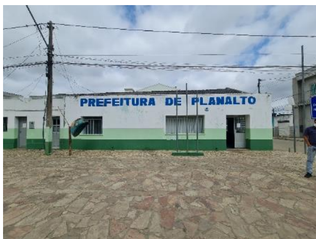
Foto 4-59: Prefeitura Municipal. Coordenadas: -14° 40' 7,67", -40° 28' 31,32". Data: 02/04/2021.
