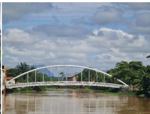
Foto 4-114: Ponte. Nova Venécia, Espírito Santo. Coordenadas: -18° 42' 8,79", -40° 24' 6,86". Data: 12/03/2021.
