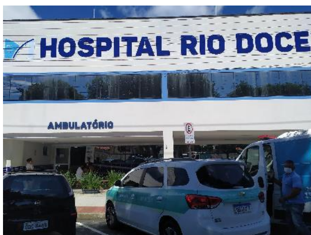
Foto 4-147: Hospital Rio Doce. Linhares. Data: 08/03/2021. Coordenadas: -19° 23' 41,21", -40° 4' 7,7".
