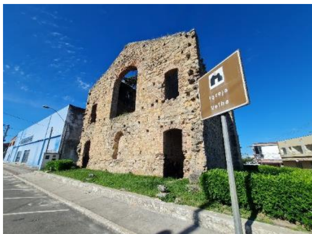
Foto 4-153: Ruínas da Igreja Velha. Sítio Histórico do Porto de São Mateus. São Mateus, Espírito Santo. Data: 13/03/2021. Coordenadas: -18° 42' 55,91", -39° 51' 30,19".
