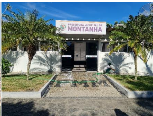
Foto 4-110: Prefeitura. Montanha, Espírito Santo. Coordenadas: -18° 7' 31,96", -40° 22' 8,51". Data: 16/03/2021.
