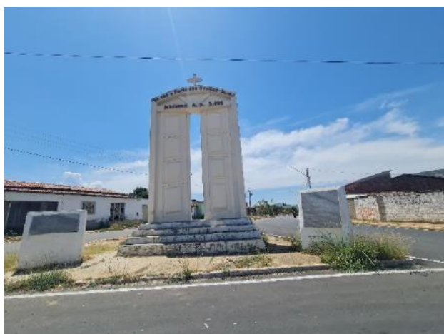
Foto 4-23: Entrada da cidade. Itambé, Bahia. Coordenadas: -15° 15' 11,67", -40° 37' 18,6". Data: 31/03/2021.
