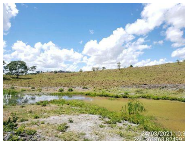
Foto 4.3-269: Barramento em córrego.
