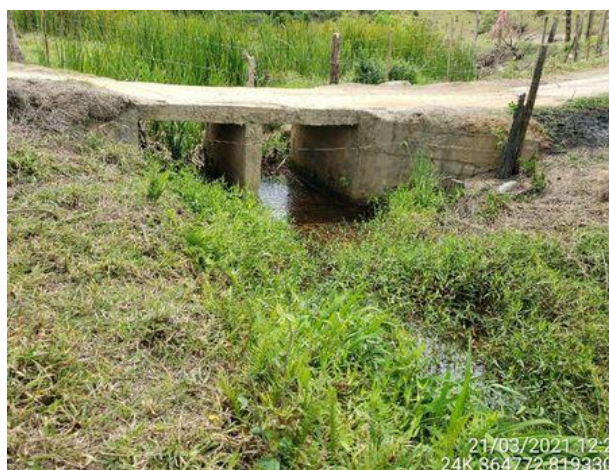
Foto 4.3-257: Córrego em travessia com a estrada.
