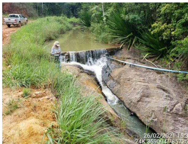
Foto 4.3-98: Barreira d'água em córrego.
