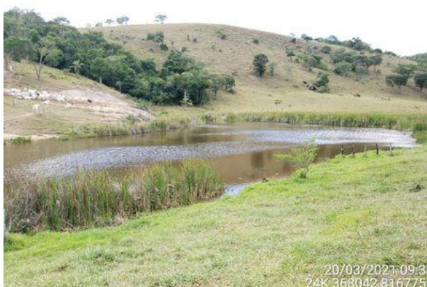
Foto 4.3-246: Barramento em córrego.
