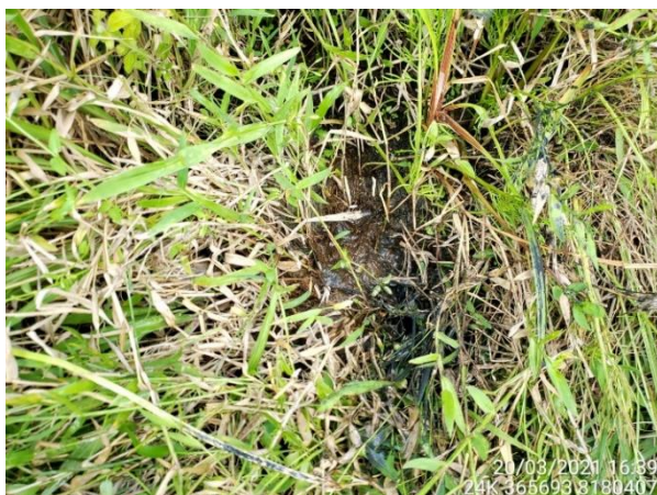
Foto 4.3-310: Solo encharcado próximo à cavidade.
