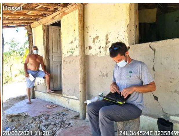
Foto 5-59: Divulgação do empreendimento. Fazenda Village. Sr. Silvano Pinheiro Souza, morador. Jordânia/MG – 28/03/2021.
