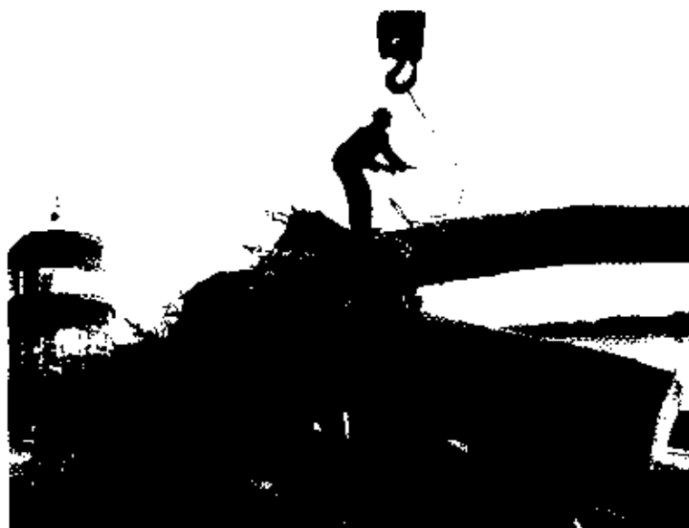
Figura 19 – Ajudante da equipe desatando os cabos de aço.
