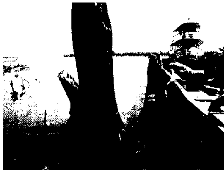
Figura 23 – Retirada dos “paliteiros” na Passagem da Ilha dos Periquitos/Curicaca.
