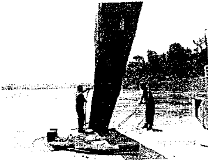
Operários envolvendo o tronco com o cabo de aço do guindaste para continuar içamento
