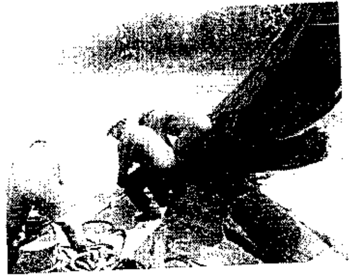
Equipe da balsa providenciando amarração do cabo de aço ao redor de tronco para remoção para o pátio da balsa
