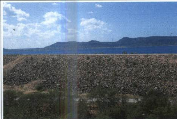
Imagem 48: Petrolândia/PE, barragem de Itaparica
