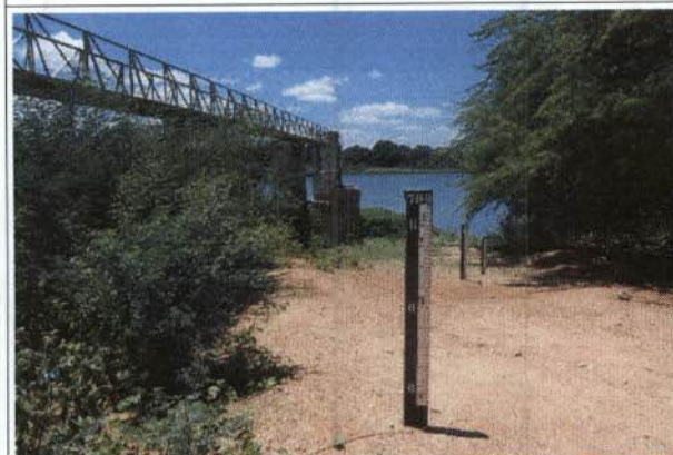
Imagem 39: Belém do São Francisco/PE - Régua Limnimétrica no ponto de captação para abastecimento urbano
