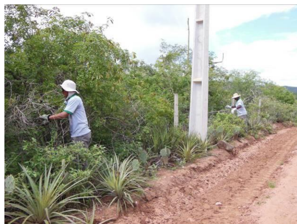
Foto 66 - Manutenção e retirada de galhos caídos sobre a cerca de concreto próximo a Área 13.
