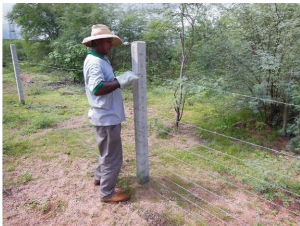
Foto 63 - Manutenção e reaperto do arame da cerca de concreto próximo a Área I.
