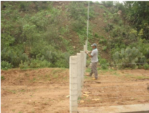
Foto 67 - Manutenção e reaperto de arame farpado e fixação dos mesmos com arames lisos nº 16 e 18 da cerca de concreto.
