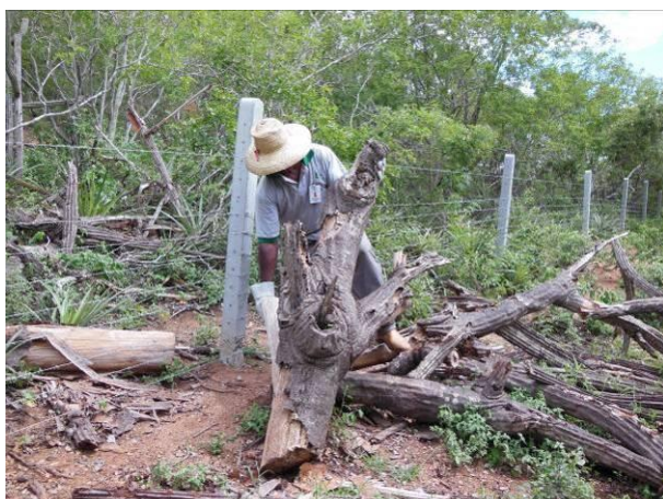
Foto 65 - Manutenção e retirada de galhos caídos sobre a cerca de concreto próximo a clareira 05.
