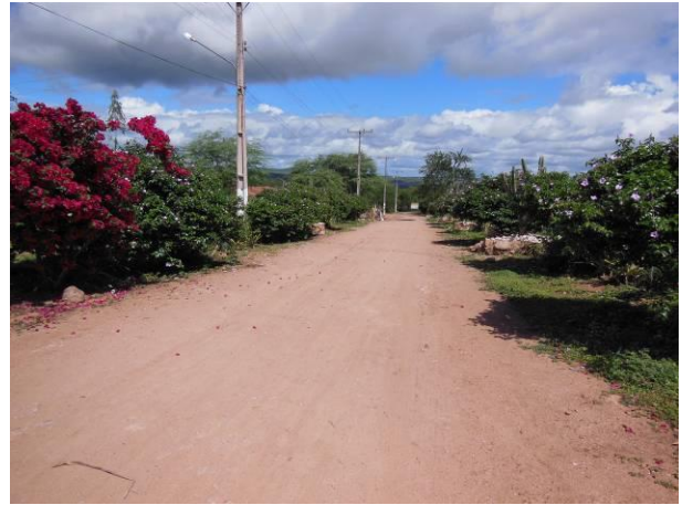
Foto 34 - Vista geral do acesso ao Viveiro após a realização dos trabalhos.
