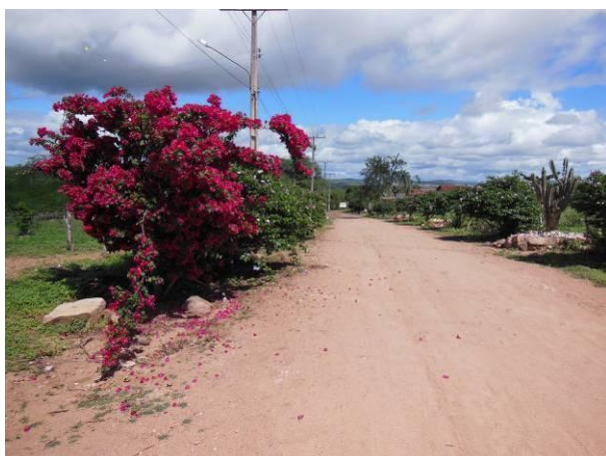
Foto 45 - Manutenção da estrada e paisagem ao acesso a sementeira da UHE Xingó.
