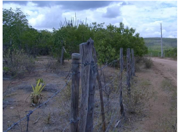
Foto 68 - Manutenção e reaperto de arame farpado e fixação dos mesmos da cerca de madeira.
