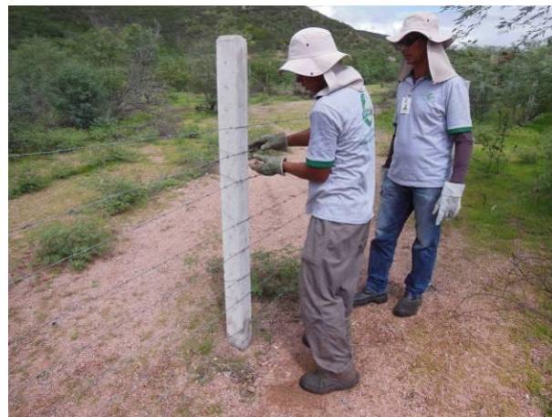
Foto 64 - Detalhe da substituição da estaca de concreto quebrada e fixação do arame situada na Área II em frente à Barragem.
