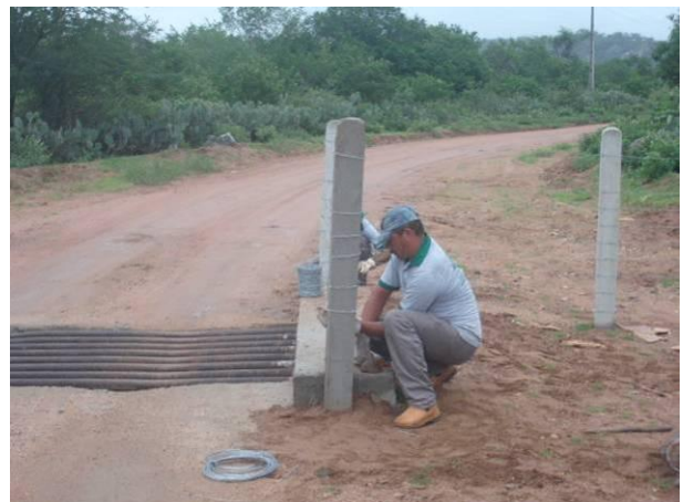
Foto 62 - Detalhe da substituição de Mourão de concreto quebrado nas proximidades do mata-burro de acesso ao Dique II.
