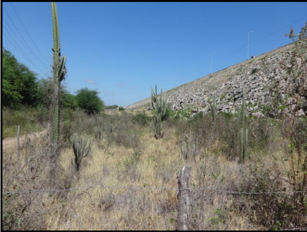
Figura 39. Visão geral da área. Foto: CARUSO JR., 2015.
