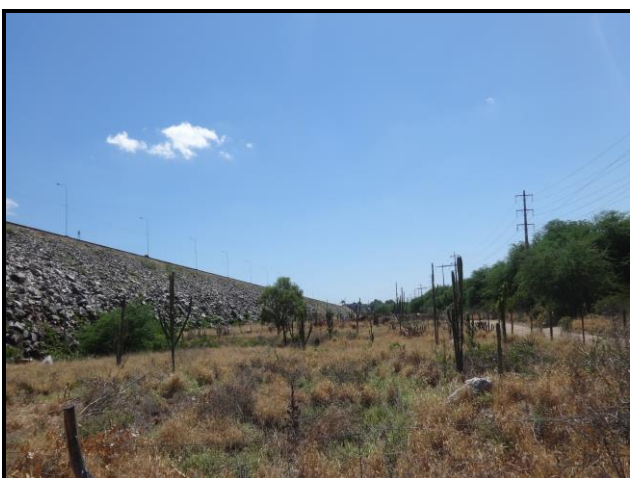
Figura 43. Visão geral da área. Foto: CARUSO JR., 2015.
