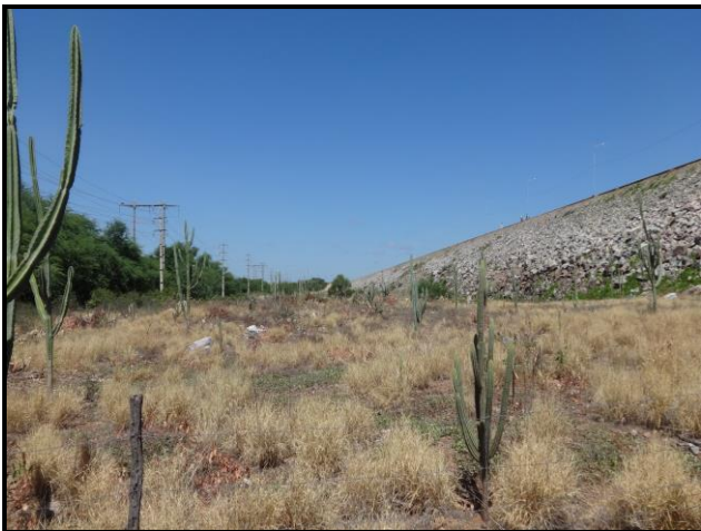
Figura 42. Visão geral da área. Foto: CARUSO JR., 2015.
