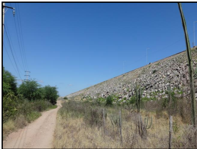
Figura 40. Visão geral da área. Foto: CARUSO JR., 2015.
