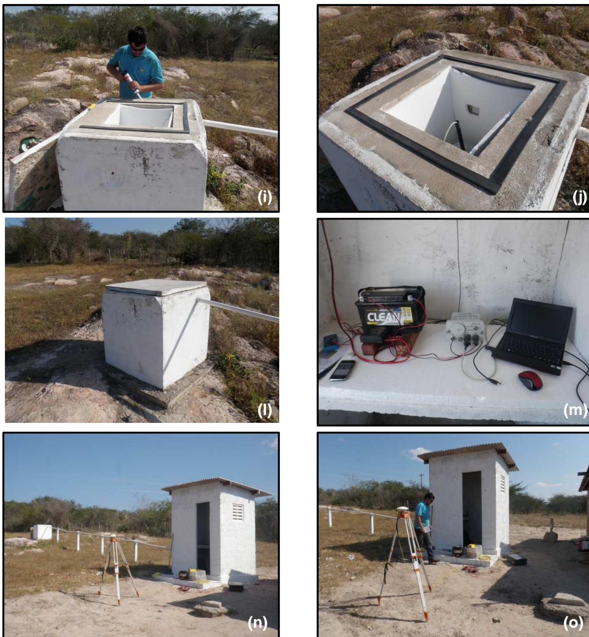
Figura 06: Mostra o passo a passo da instalação da estação sismográfica XIN 01, sendo: (A) a (D) Instalação do painel solar e antena GPS Trimble sobre o teto do abrigo da estação; (E) a (G) Instalação do sismômetro dentro do abrigo, assim como o posicionamento e orientação em relação ao norte do sensor com bússola de precisão; (H) a (L) Acondicionamento e isolamento térmico do abrigo do sensor do sismógrafo; (M) Vista do interior do abrigo com os equipamentos instalados e em funcionamento; (N) e (O) Vista lateral da estação sismográfica da UHE de Xingó - XIN 01, sendo rastreada por GPS geodésico de precisão.
