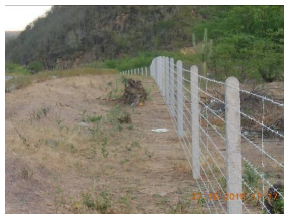
Foto 56 - Vista geral da cerca de concreto finalizada na área clareira 01.
