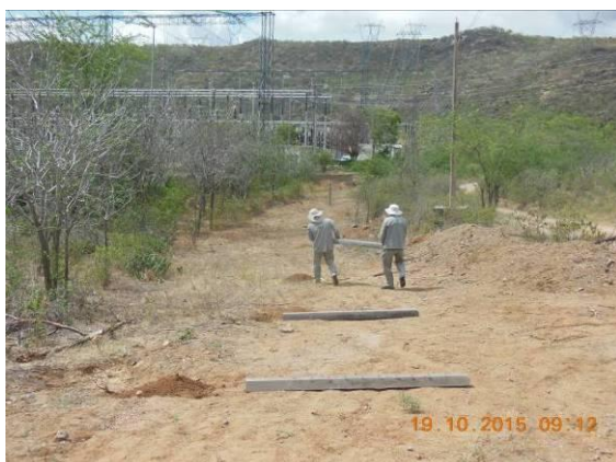
Foto 53 - Distribuição das estacas e mourões no campo.
