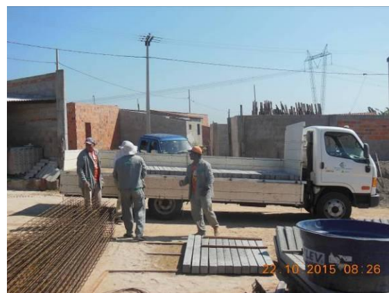
Foto 54 - Vista geral do apoio e material utilizado para implantação do cercamento da área de reserva clareira 01.
