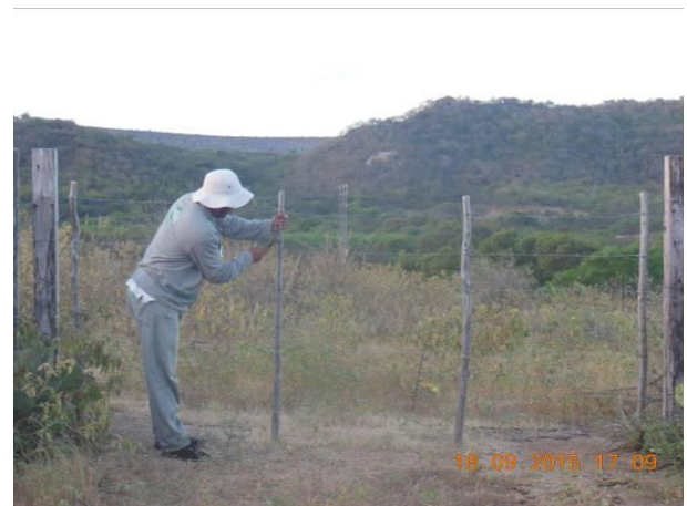
Foto 44 - Manutenção de cancela da área 09.
