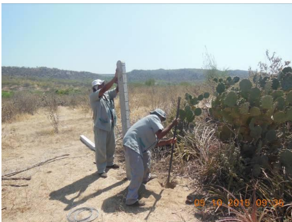
Foto 43 - Substituição de estaca de concreto quebrada existente nas proximidades da área 11.
