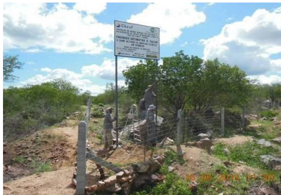
Foto 59 - Placa informativa 02 instalada na área degradada no entorno do Viveiro Florestal. Coordenadas UTM E 634426 e UTM N 8936933.
