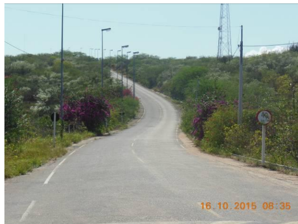
Foto 24 - Limpeza nas margens da estrada de acesso a área superior da barragem.
