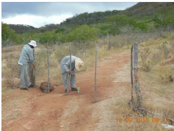
Foto 45 - Manutenção da cancela de acesso na área 06.
