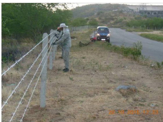
Foto 55 - Etapa de lançamento dos fios de arame farpado próximo clareira 01.
