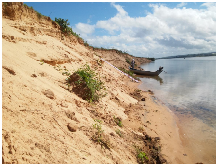
Figura 6.79 e 6.80 - Visão do barranco e da margem
