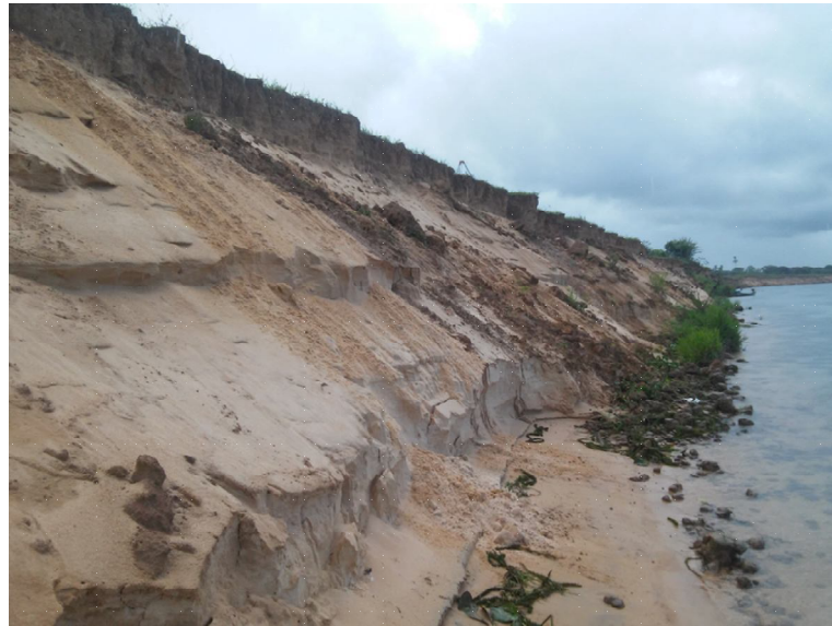
Figura 6.85 e 6.86 - Visão do barranco e da margem
