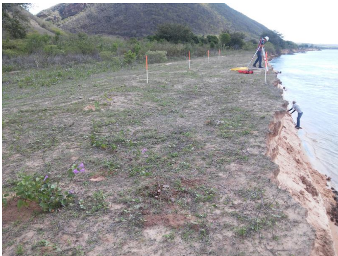
Figura 6.76 e 6.77 - Visão do barranco e da margem
