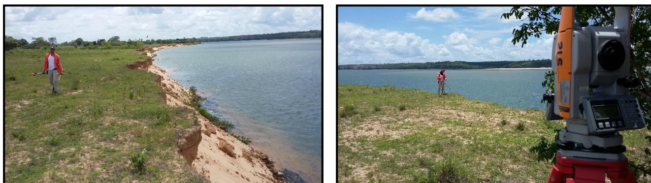
Figura 2.16 Vista da estação EM B-10 evidenciando detalhe com solo arenoso, com pouca cobertura vegetal.
