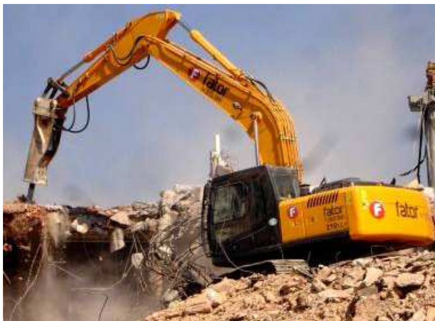
Figura 04. Exemplo de máquina e Rompedor hidráulicos necessários para a demolição nas áreas com remanescente de obras.
