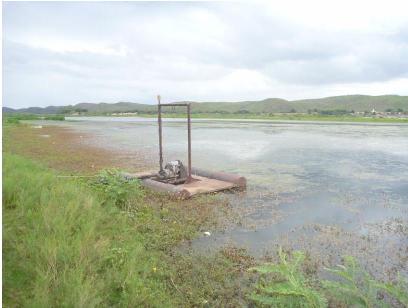
Bomba de captação da DESO-SE sem nenhum tipo de proteção no seu entorno
