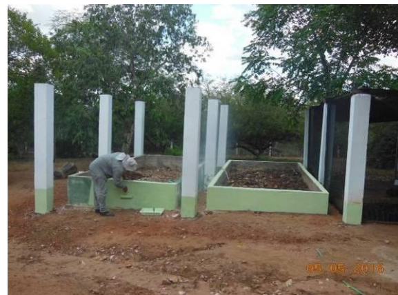
Foto 30 - Manutenção e pintura da composteira.
