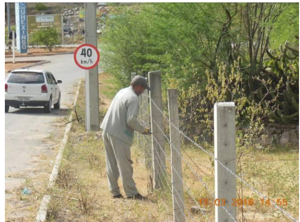
Foto 38 - Detalhe da substituição de estaca e manutenção da cerca nas proximidades da Área 01.
