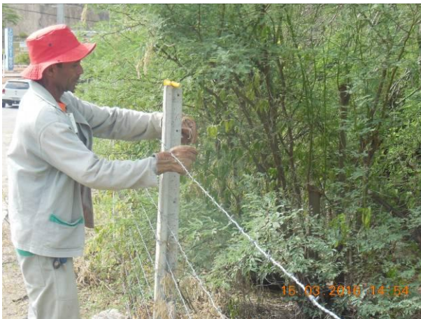
Foto 37 - Manutenção do arame da cerca de concreto existente nas proximidades da Área 01.
