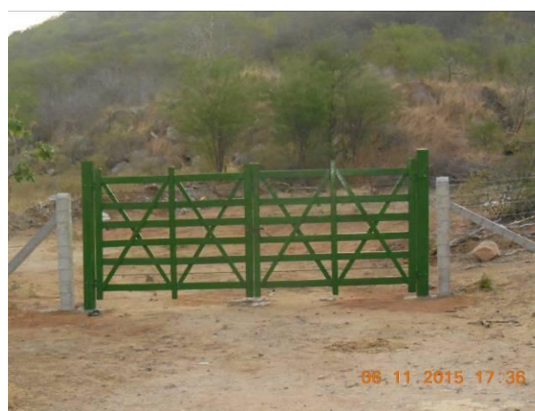
Foto 96 - Cancela 02 - Localizada próximo a SE 500 kV de Xingó. Coordenadas UTM E 631998 e UTM N 8935165.
