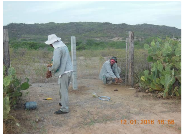
Foto 48 - Detalhe da substituição de estaca e manutenção da cerca nas proximidades da Área 11.
