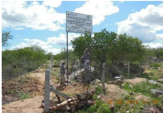
Foto 85 - Placa informativa 02 instalada na área degradada no entorno do Viveiro Florestal. Coordenadas UTM E 634426 e UTM N 8936933.
