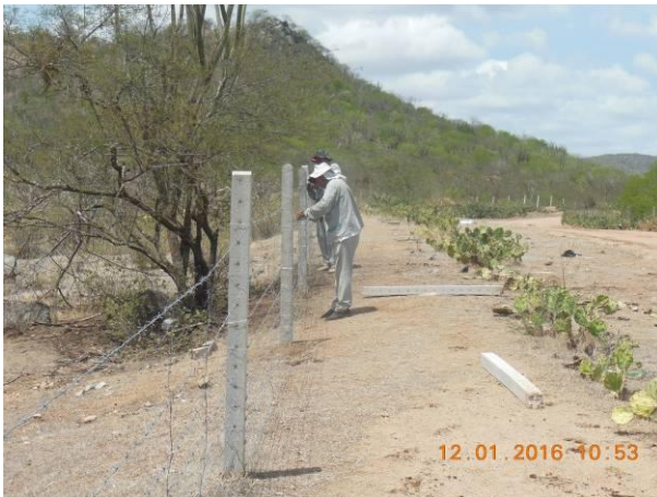
Foto 47 - Manutenção do arame da cerca de concreto existente nas proximidades da Área 11.
