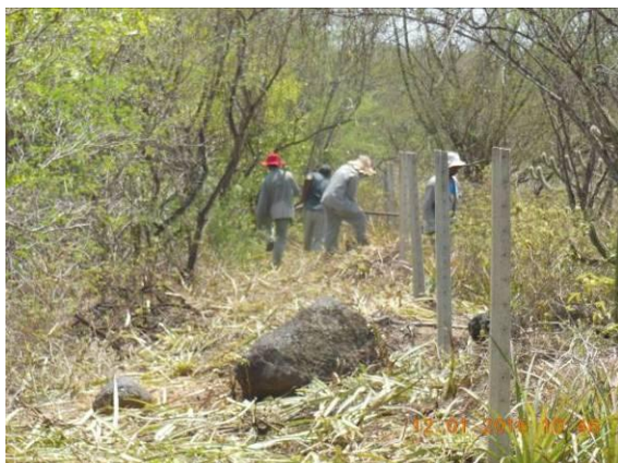
Foto 81 - Manutenção de picada para início da construção de cerca.
