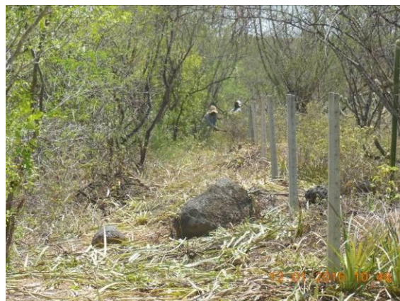
Foto 82 - Outra vista dos trabalhos de manutenção e reabertura de picada para início de construção de cerca.
