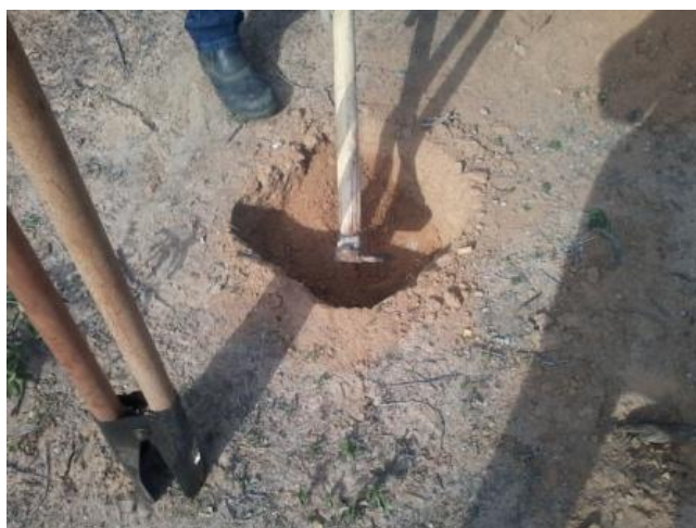
Foto 80 - Exemplo proposto para o coveamento manual com a utilização de cavadeira.
