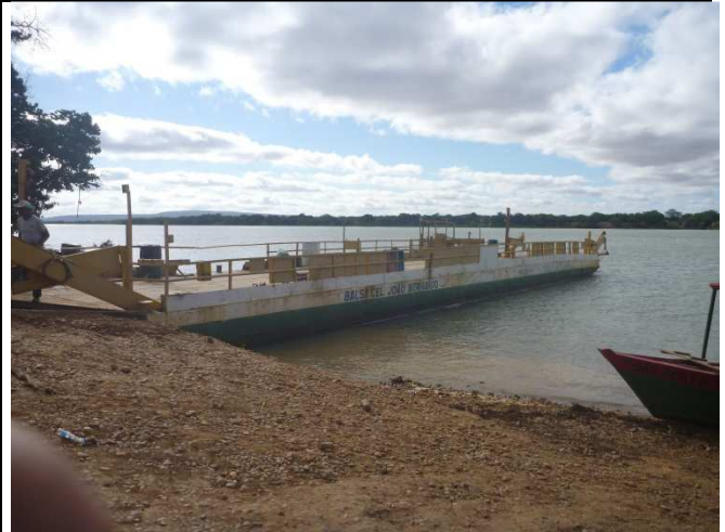
Atracodouro balsa lado Santa M. da Boa Vista-PE
