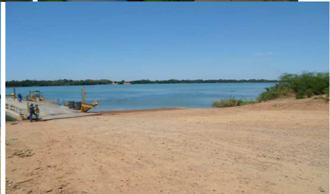
Curaçá -BA - 10/12/2015 (nas duas ultimas imagens vemos o registro porto da balsa que, em função da diminuição da vazão do rio, foi aterrado avançando mais de 02 metros para dentro área da calha do rio para permitir a continuidade da atividade das travessias das balsas e outras embarcações).
