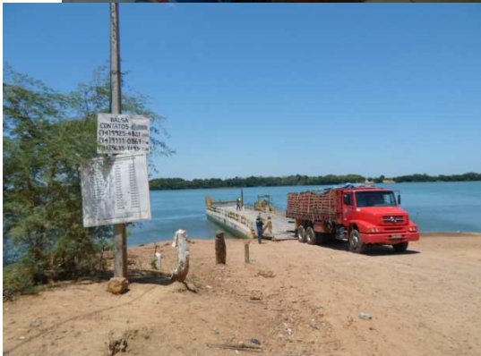
Curaçá -BA - 10/12/2015 (nas duas ultimas imagens vemos o registro porto da balsa que, em função da diminuição da vazão do rio, foi aterrado avançando mais de 02 metros para dentro área da calha do rio para permitir a continuidade da atividade das travessias das balsas e outras embarcações).
