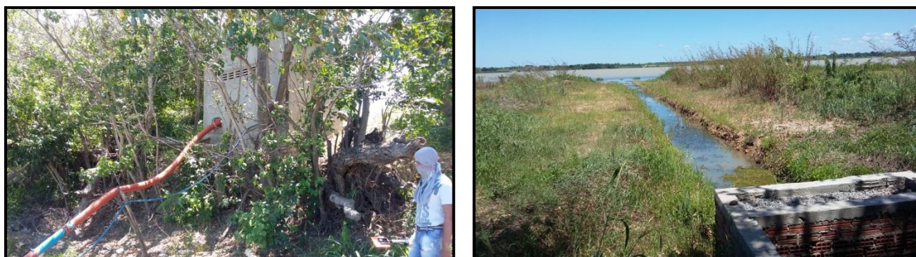
Figura 2.7. Vistas da estação EM 2.1, a esquerda casa de bombas, e presença de certa cobertura vegetal (direita).
