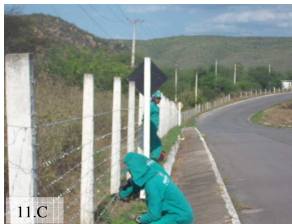
Figura 11 – Construção de cerca de arame farpado
