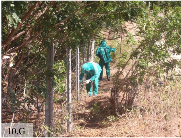
Figura 10 – Construção de cerca de arame farpado
