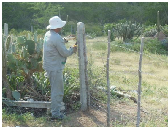
Foto 25 - Substituição de estaca quebrada na área 08.
