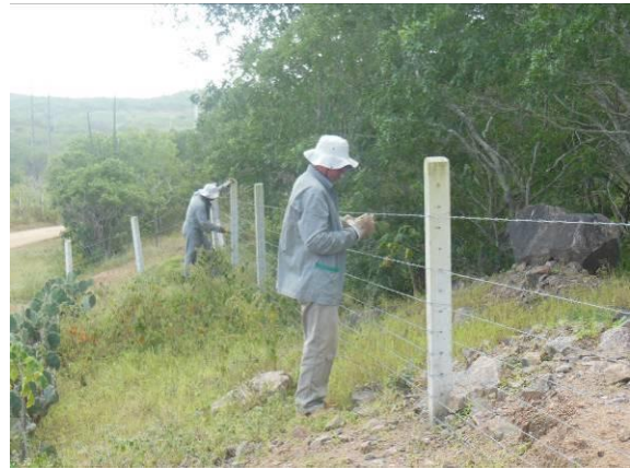
Foto 24 - Manutenção da cerca nas proximidades do acesso ao dique II.
