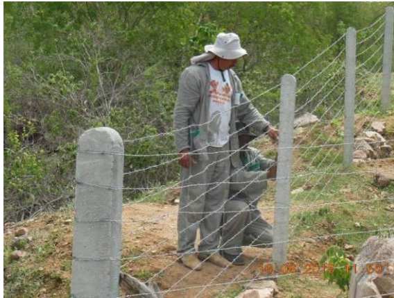
Foto 23 - Manutenção do arame da cerca de concreto existente nas proximidades do viveiro florestal.
