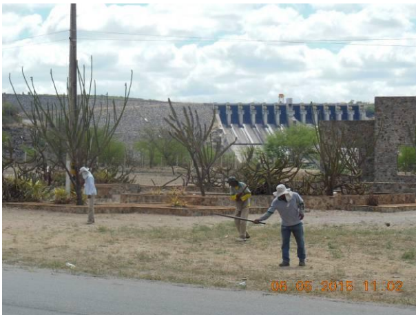
Foto 55 - Limpeza e roço das margens do acesso área do aterro.
