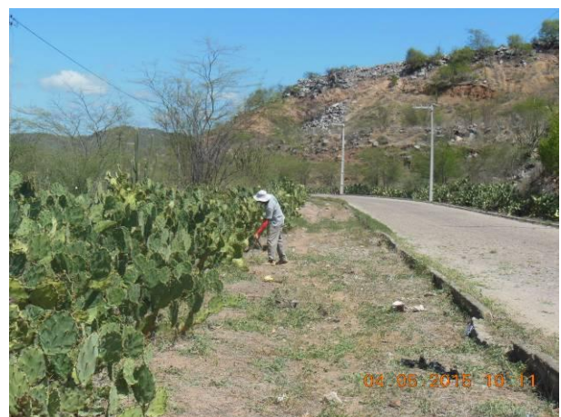
Foto 54 - Limpeza e roço das margens do acesso próximo a guarita.
