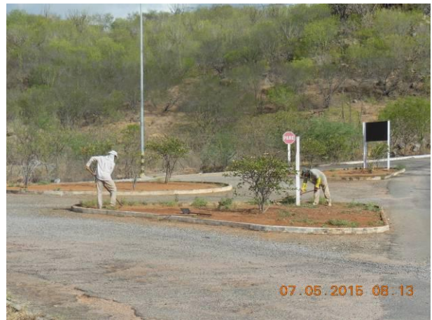
Foto 56 - Limpeza e roço trevo de acesso ao a estação 500kw.
