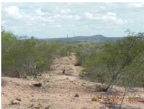
Foto 93 - Abertura de 1.616 metros de picada no entorno da reserva para implantação de cerca de concreto.
