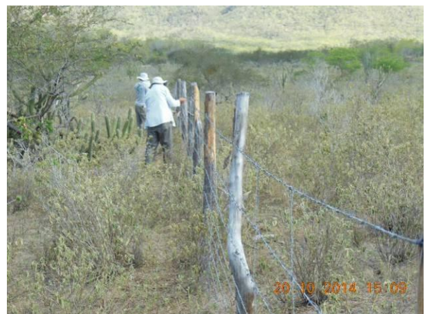
Foto 82 - Alinhamento e fixação de arame na área de reserva.
