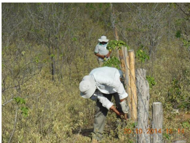
Foto 81 - Manutenção da cerca de madeira e substituição de estaca de madeira.
