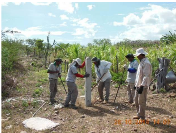
Foto 95 - Vista geral da implantação de mourão de concreto para cercamento da área de reserva próximo ao Viveiro.
