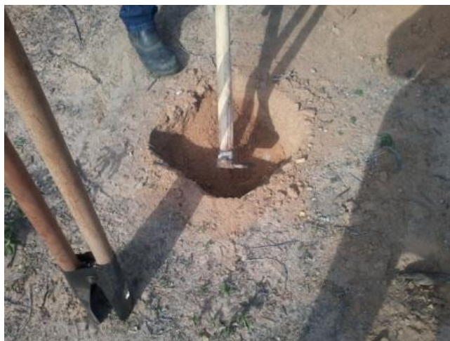
Foto 92 - Exemplo proposto para o coveamento manual com a utilização de cavadeira.
