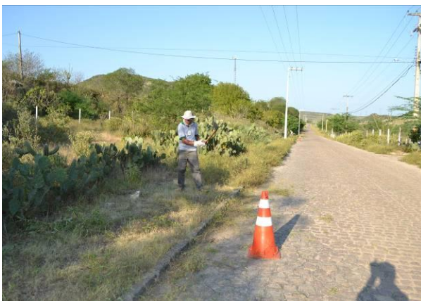
Foto 47 - Limpeza e roço das margens do acesso no trecho da praça do aterro até a guarita principal da UHE Xingó.
