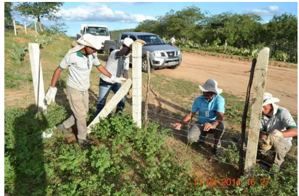
Foto 54 - Detalhe da substituição de estaca e manutenção da cancela de arame nas proximidades do mata-burro de acesso ao Dique III.
