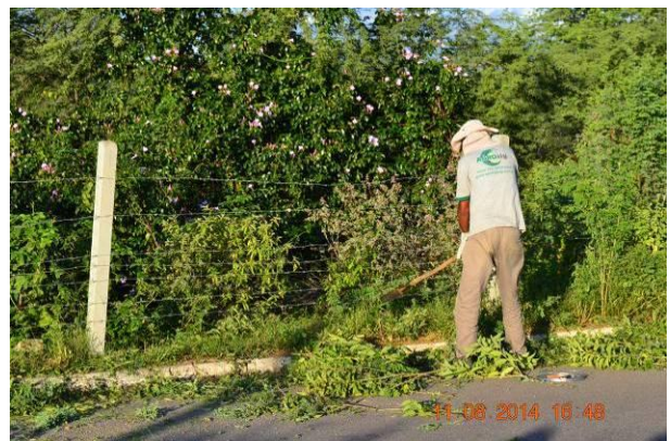
Foto 58 - Roçada e reaperto de arame farpado e fixação da cerca de concreto na Área I.
