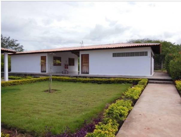
Foto 39 - Vista geral do escritório (direita) e auditório (esquerda) no Viveiro Florestal na UHE Xingó.
