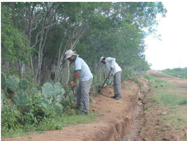
Foto 61 - Limpeza e manutenção da cerca viva de palma espinhosa entre o Dique II e a Área 11.
