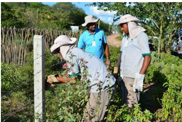
Foto 57 - Manutenção e reaperto de arame farpado e fixação com arames lisos nº 16 e 18 da cerca de concreto.
