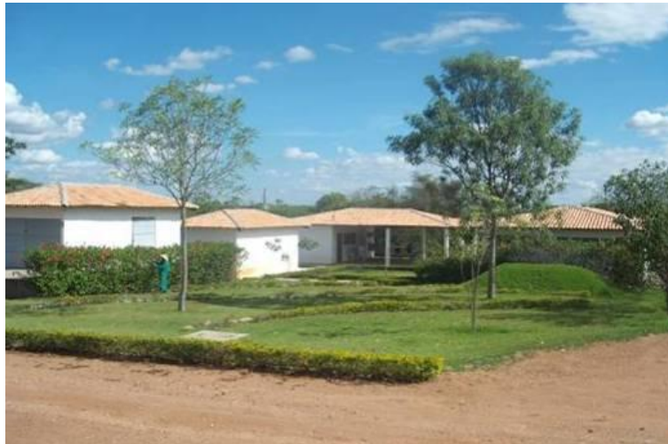
Foto 6 - Vista geral do escritório e demais instalações destinadas à secagem e classificação de sementes de qualidade para posterior processamento e utilização para o plantio.
