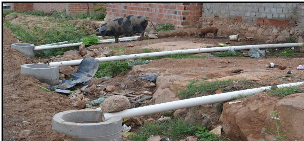
Figura 2.37. Rede de esgoto condominial em construção no povoado da Barragem Leste
