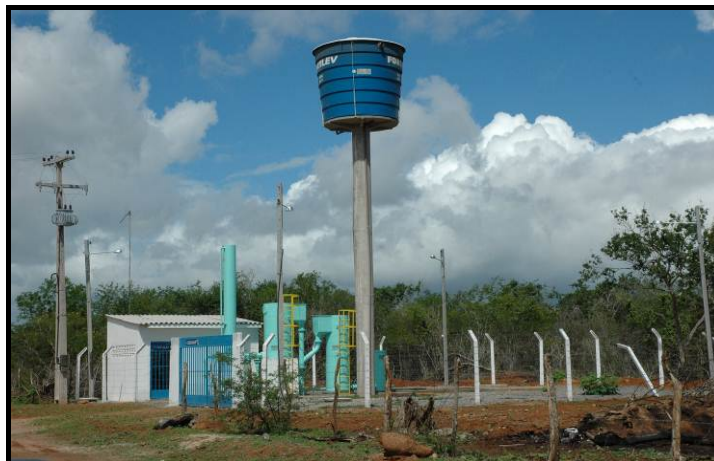
Figura 2.33. Sistemas compactos de abastecimento de água em comunidades rurais - CODEVASF - Comunidade do Talhado
