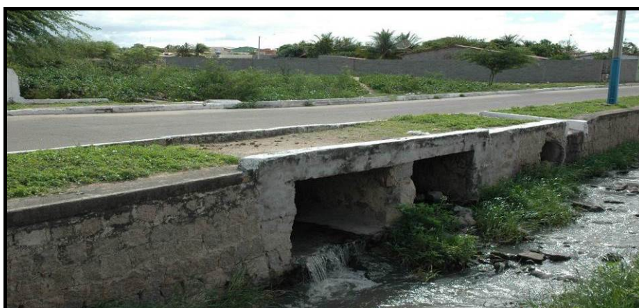
Figura 2.34. Coletor de esgoto lançando na macrodrenagem na Área Urbana de Delmiro Gouveia
