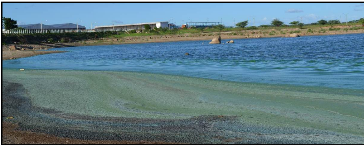
Figura 2.40. Reservatório que barra o Rio Maxixe, Coletor de esgotos de Delmiro Gouveia
