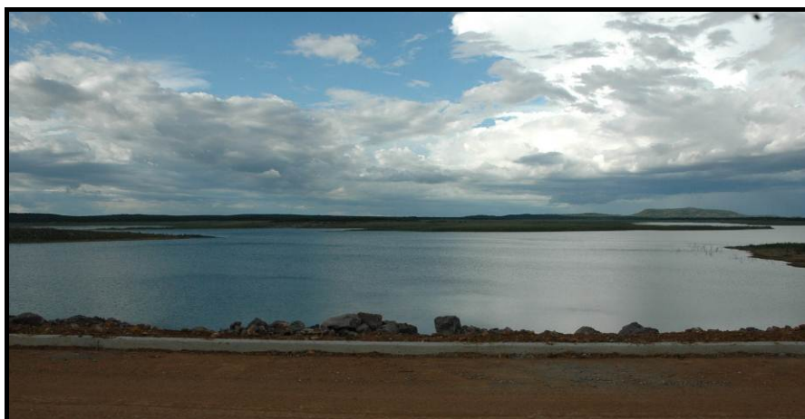
Figura 2.1. Reservatório Eng. Francisco Saboia (Poço da Cruz)
