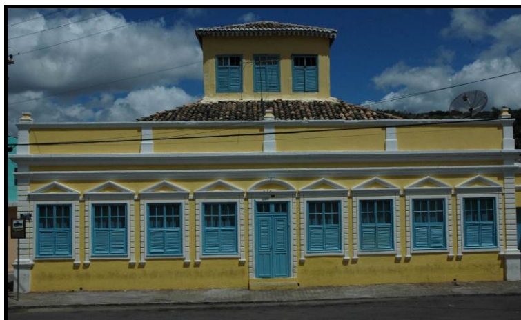
Figura 2.70. Casa do Barão de Água Branca
