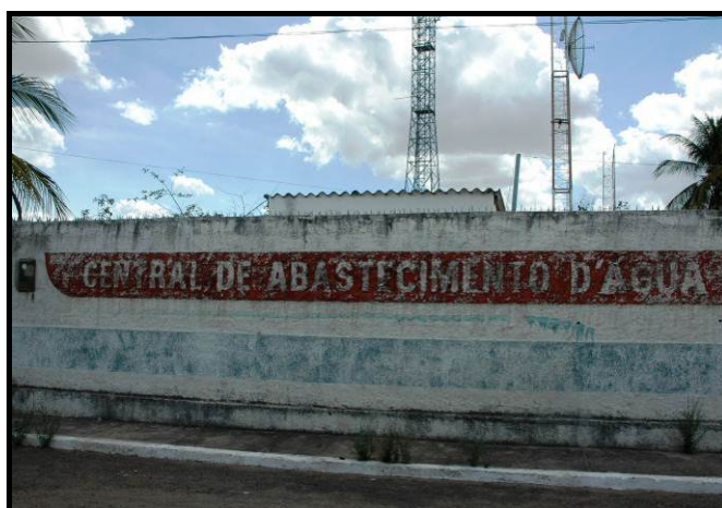
Figura 2.13. Central de Abastecimento de Água em Volta do Moxotó
