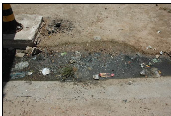
Figura 2.24. Vista do Sistema de Drenagem do povoado de Caraibeiras em Tacaratu
