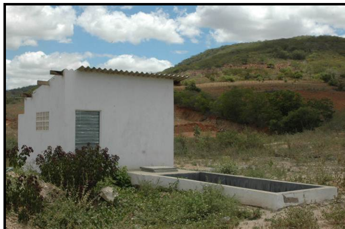
Figura 2.52. Implantação do esgotamento sanitário em Pariconha – Estação de Tratamento
