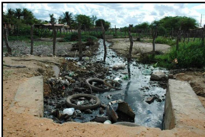
Figura 2.9. Macro drenagem evidenciando lançamento de esgotos in natura
