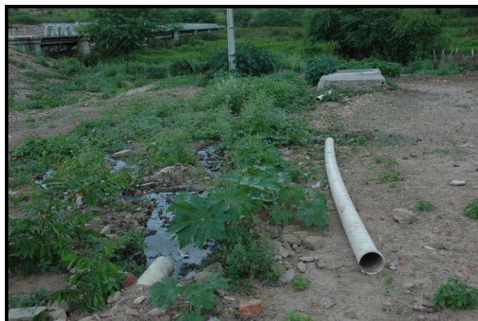
Figura 2.15. Esgoto in natura escoando diretamente para o rio em Volta do Moxotó
