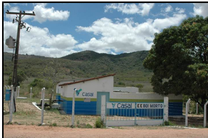
Figura 2.50. Estação Elevatória de Água da CASAL em Pariconha
