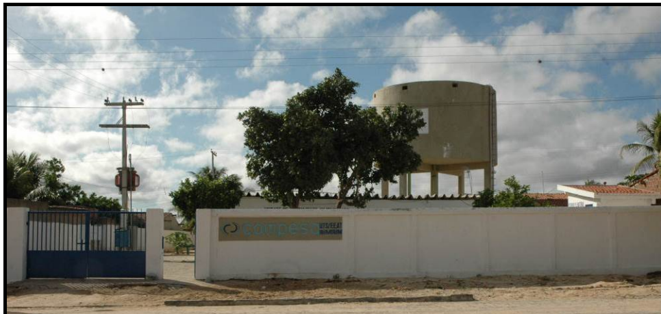
Figura 2.2. Reservatório para Abastecimento de Água da COMPESA em Ibimirim/PE
