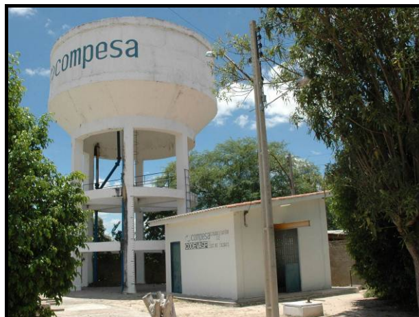
Figura 2.22. Vista do Sistema de Abastecimento de Água no povoado de Caraibeiras em Tacaratu
