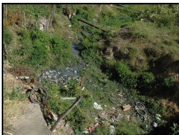
Figura 2.46. Lançamento de esgoto in natura no Riacho da Matança
