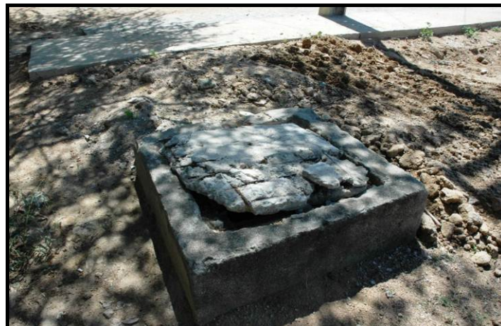
Figura 2.17. Macrodrenagem da Área Urbana da Sede de Jatobá evidenciando lançamento de esgotos in natura
