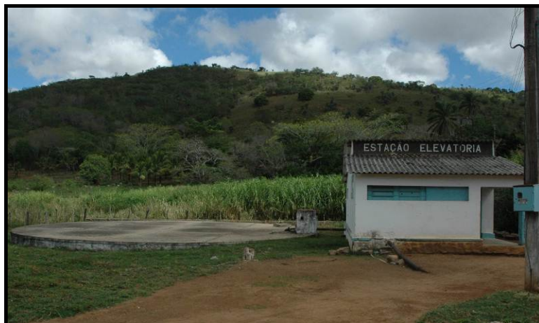
Figura 2.26. Vista do Sistema de Abastecimento de Água de Água Branca
