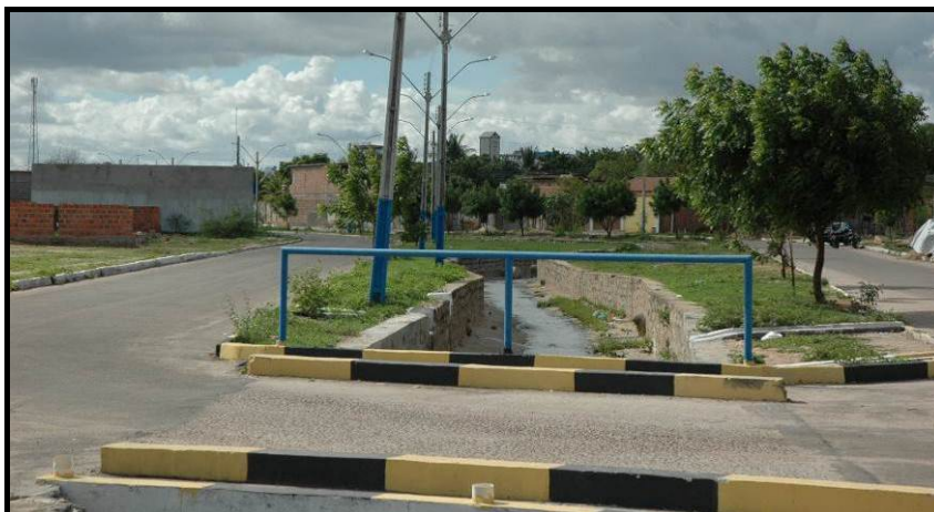
Figura 2.38. Macrodrainagem existente na Rua Lenira Pereira Alves - Área Urbana de Delmiro Gouveia
