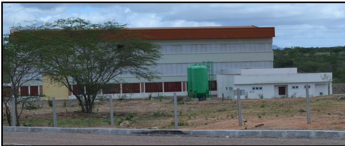
Figura 2.31. Vista da Estação Elevatória Delmiro do Canal do Sertão Alagoano
