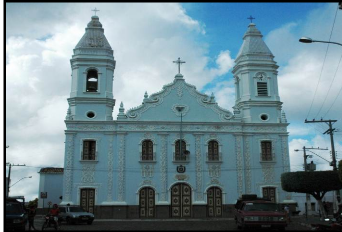
Figura 2.25. Vista da Igreja Matriz de Água Branca
