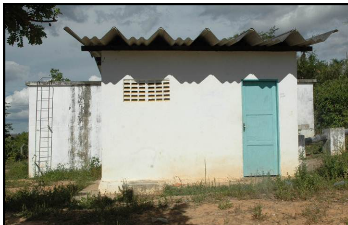
Figura 2.45. Reservatório Apoiado da Sede Municipal de Mata Grande
