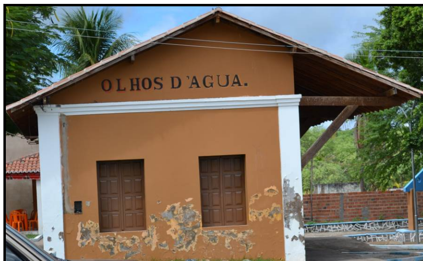
Figura 2.15. Vista atual da Estação "Olhos D'Água" da Ferrovia Piranhas - Petrolândia
