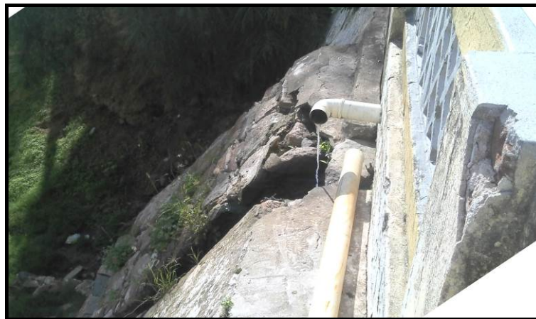
Figura 2.34. Local de lançamento de esgotos "in natura" na Orla de Entremontes - AL
