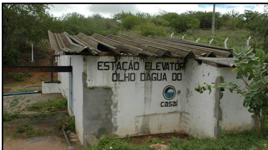
Figura 2.17. Estação Elevatória do Sistema Abastecimento de Água de Olho D'água do Casado
