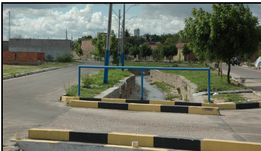
Figura 2.9. Macro drenagem existente na Rua Lenira Pereira Alves - Área Urbana de Delmiro Gouveia
