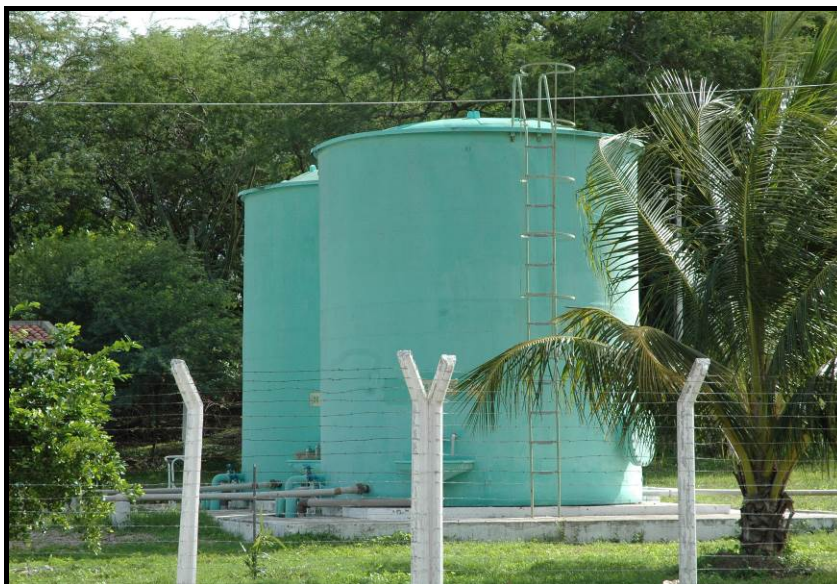
Figura 2.7. ETE Compacta - Bairro Novo - Área Urbana de Delmiro Gouveia
