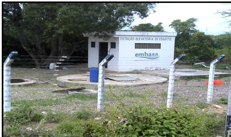
Figura 2.48. Estação Elevatória de Esgoto - EMBASA - Paulo Afonso - BA, aparentemente fora de operação
