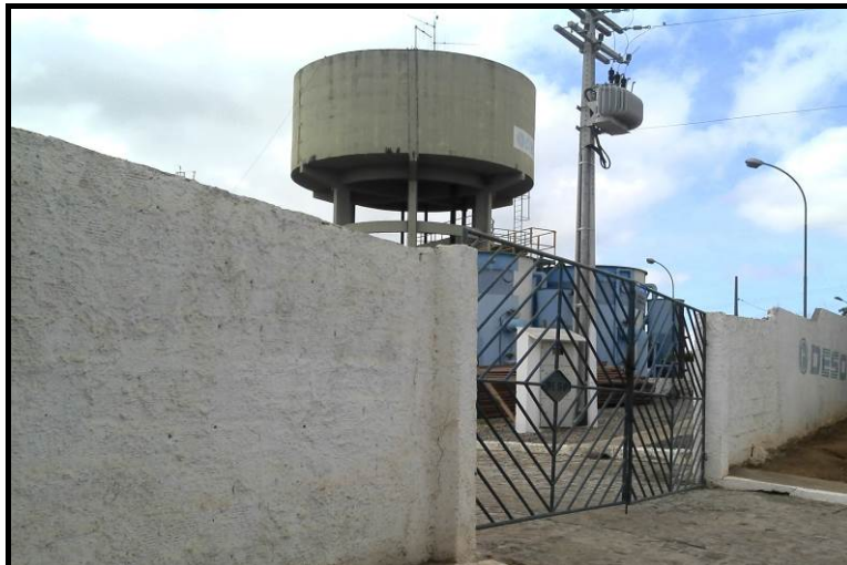
Figura 2.56: Estação de Tratamento de Água em Canindé de São Francisco, operada pela DESO
