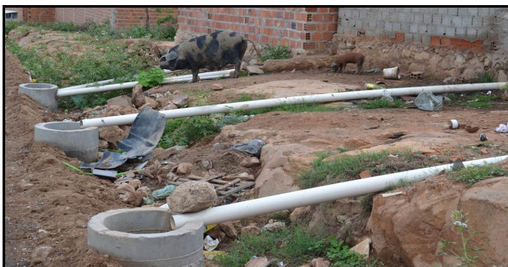
Figura 2.8. Rede de esgoto condominial em construção no povoado da Barragem Leste
