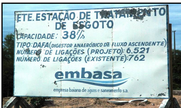
Figura 2.49. Estação de Tratamento de Esgoto - EMBASA - Paulo Afonso - BA, em construção
