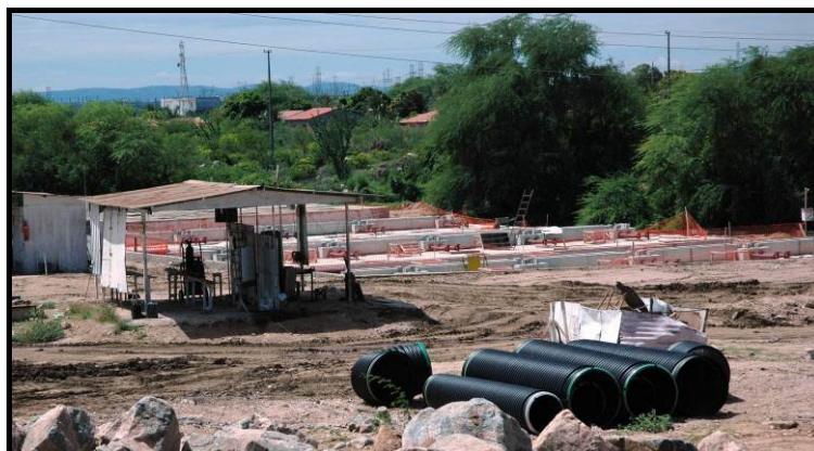
Figura 2.50. Estação de Tratamento de Esgoto - EMBASA - Paulo Afonso - BA, em construção
