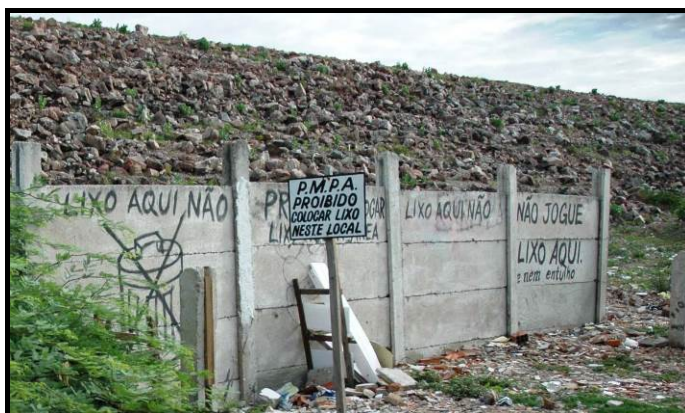
Figura 2.53: Depósitos de resíduos urbanos sem nenhum tipo de condicionamento próximo ao dreno de jusante do maciço da barragem de Paulo Afonso IV
