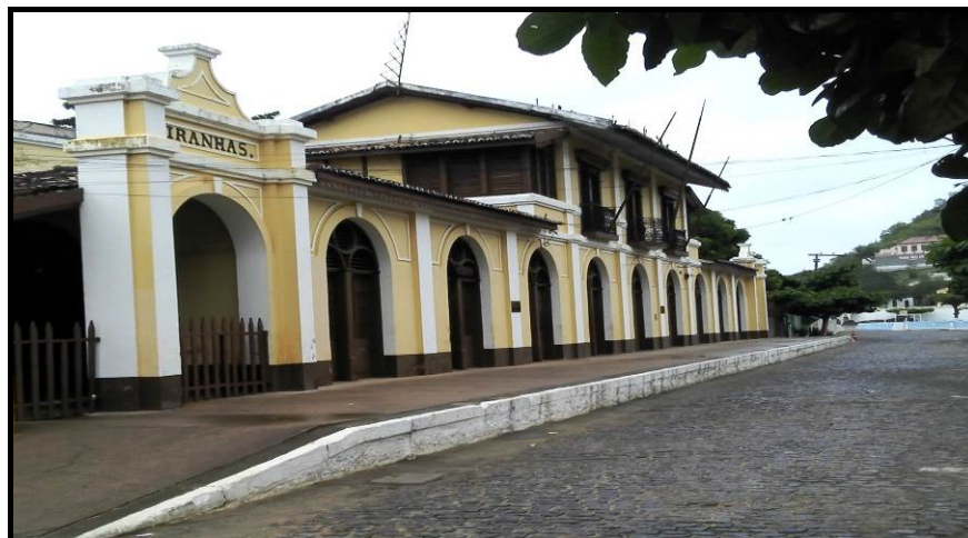
Figura 2.30. Museu do Sertão localizado na antiga Estação Ferroviária de Piranhas - AL
