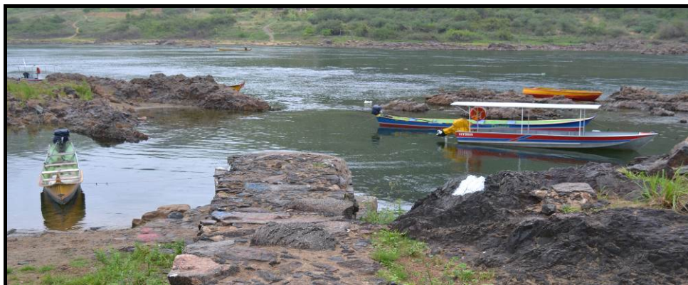
Figura 2.36. Ponto final da Rede de Drenagem de Piranhas com lançamento de esgotos "in natura"
