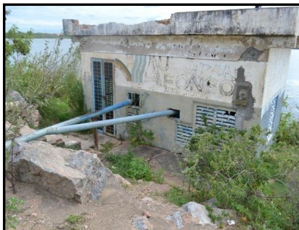
Figura 2.44. Captação de água da Prefeitura Municipal de Paulo Afonso para abastecimento humano sem tratamento do bairro Centenário
