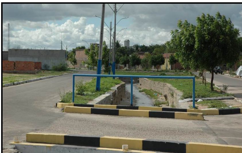
Figura 2.9. Macrodrainagem existente na Rua Lenira Pereira Alves - Área Urbana de Delmiro Gouveia
