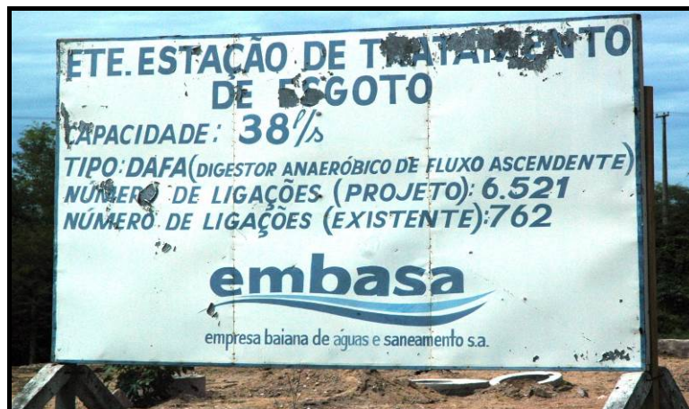
Figura 2.32. Estação de Tratamento de Esgoto - EMBASA - Paulo Afonso - BA, em construção
