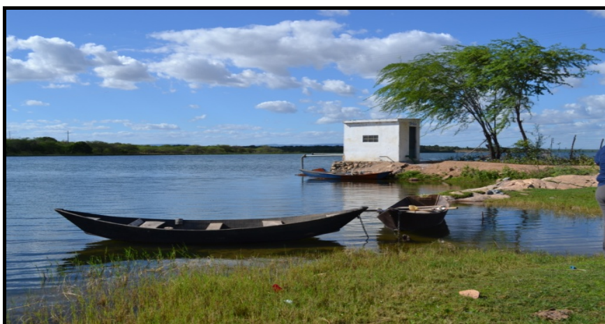
Figura 2.20. Captação de água da EMBASA para abastecimento da Sede de Glória - BA
