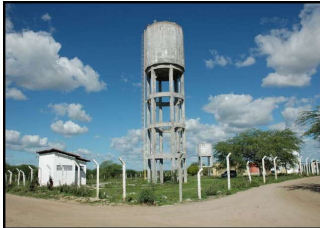
Figura 2.29. Estação de Tratamento de Água EMBASA - Paulo Afonso
