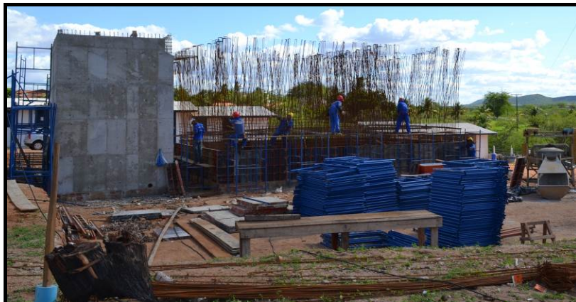
Figura 2.19. Estação de Tratamento de Água EMBASA em Glória-BA (em construção)
