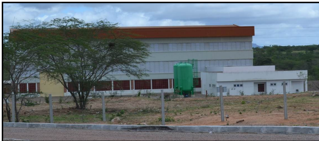
Figura 2.2. Vista da Estação Elevatória Delmiro do Canal do Sertão Alagoano
