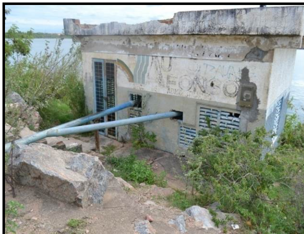
Figura 2.27. Captação de água da Prefeitura Municipal de Paulo Afonso para abastecimento humano sem tratamento do bairro Centenário
