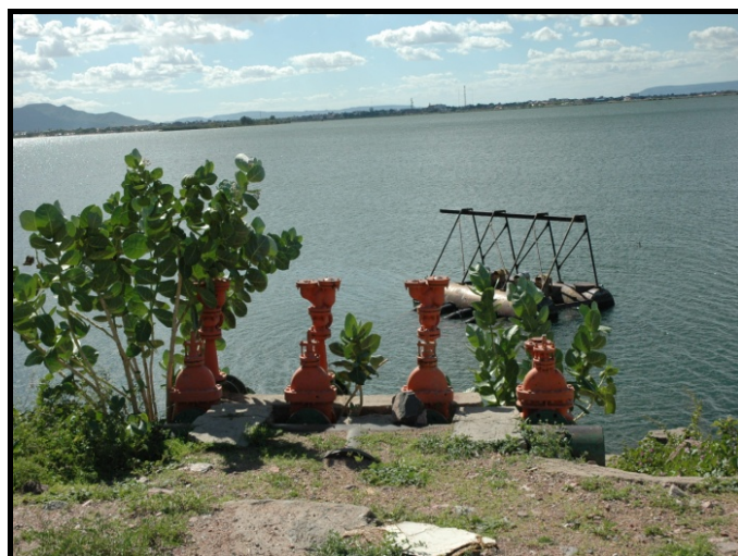
Figura 2.30. Segunda Captação de água pela EMBASA - Paulo Afonso para abastecimento humano, inclusive com sistema de tratamento
