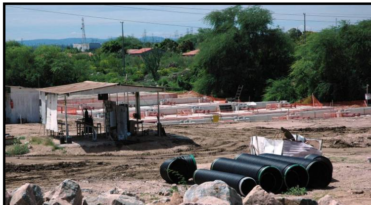
Figura 2.33. Estação de Tratamento de Esgoto - EMBASA - Paulo Afonso - BA, em construção
