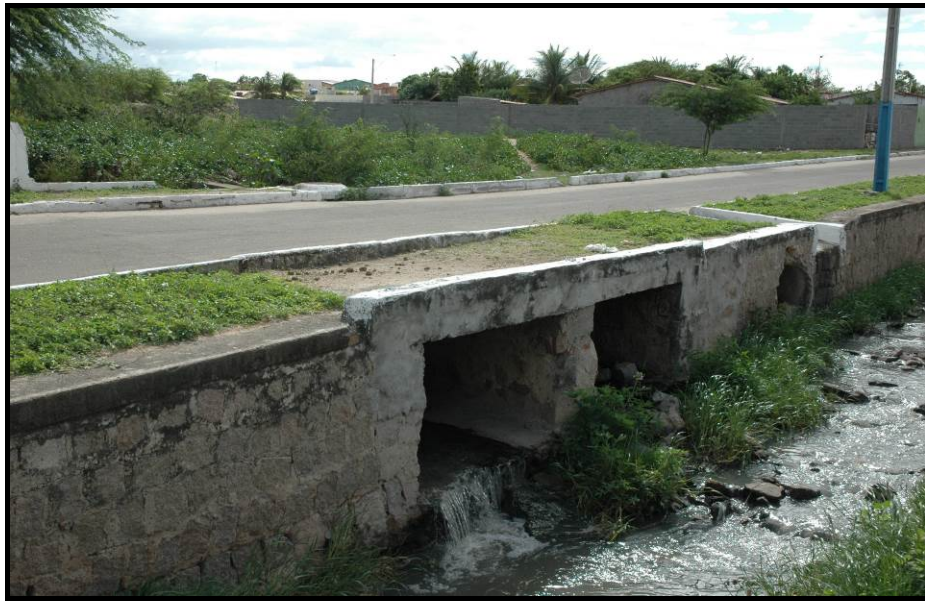
Figura 2.5. Coletor de esgoto lançando na macrodrenagem na Área Urbana de Delmiro Gouveia
