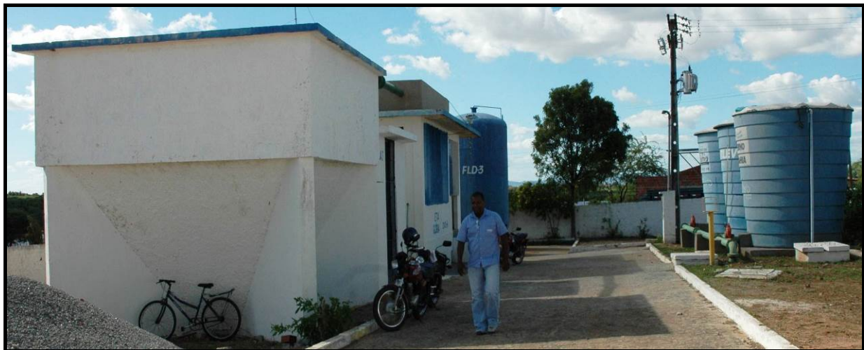
Figura 2.18. Estação de Tratamento de Água EMBASA em Glória-BA (em operação)
