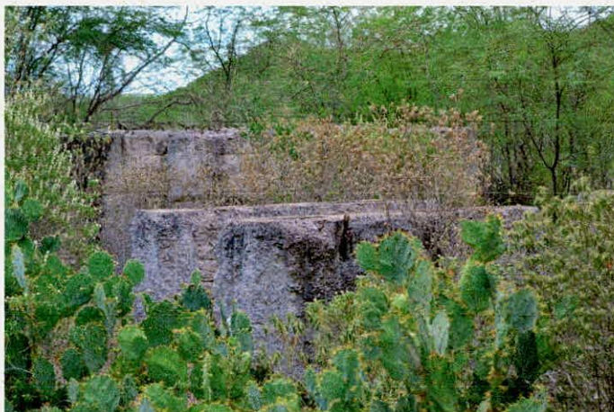
Figura 03. Estrutura em concreto, sendo cobertos lentamente pelo ambiente da caatinga.
