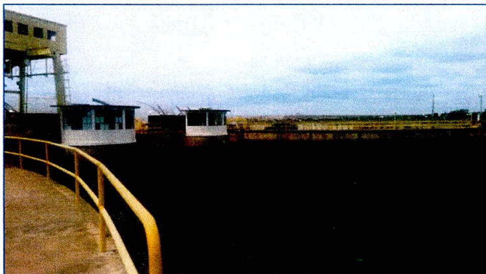
Tomada D'água da Usina Paulo Afonso I – BA
