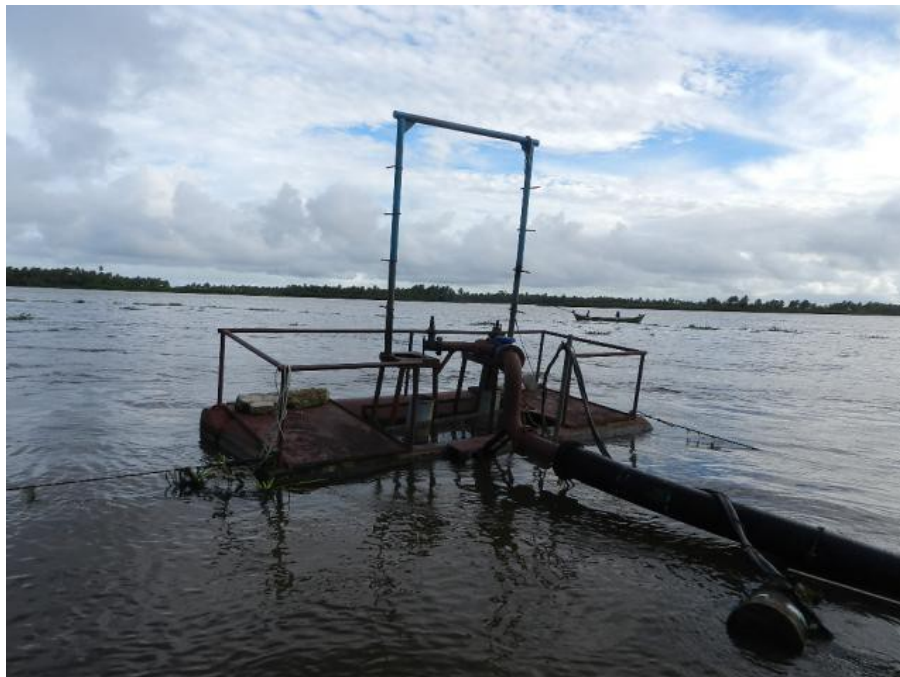
Figura 48: Sistema de captação de água de Piaçabuçu-AL. Fonte: IBAMA.
