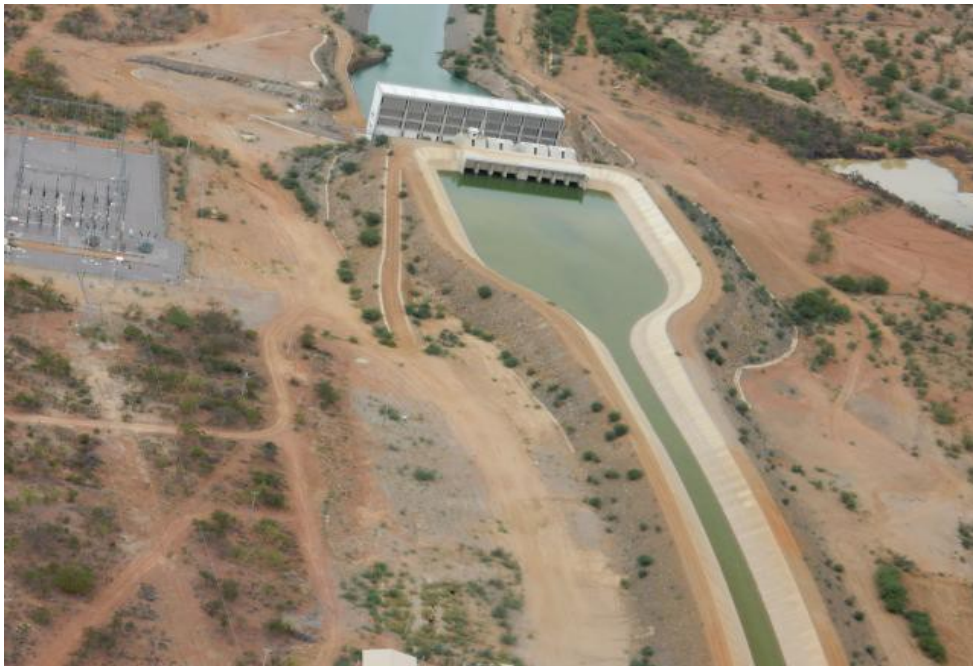
Figura 38: Sistema de Transposição do rio São Francisco eixo leste. Fonte: IBAMA.
