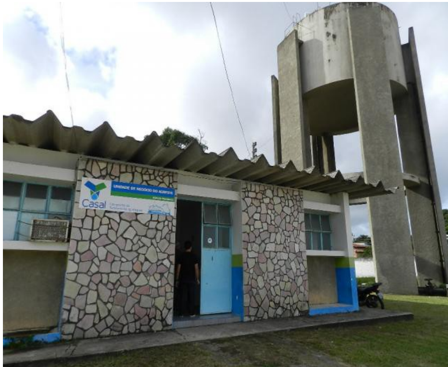
Figura 47: ETA de Piaçabuçu-AL. Fonte: IBAMA.
