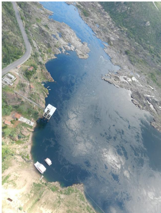
Figura 12: Sistema de captação de água próximo a jusante da UHE Xingó. Fonte: IBAMA.
