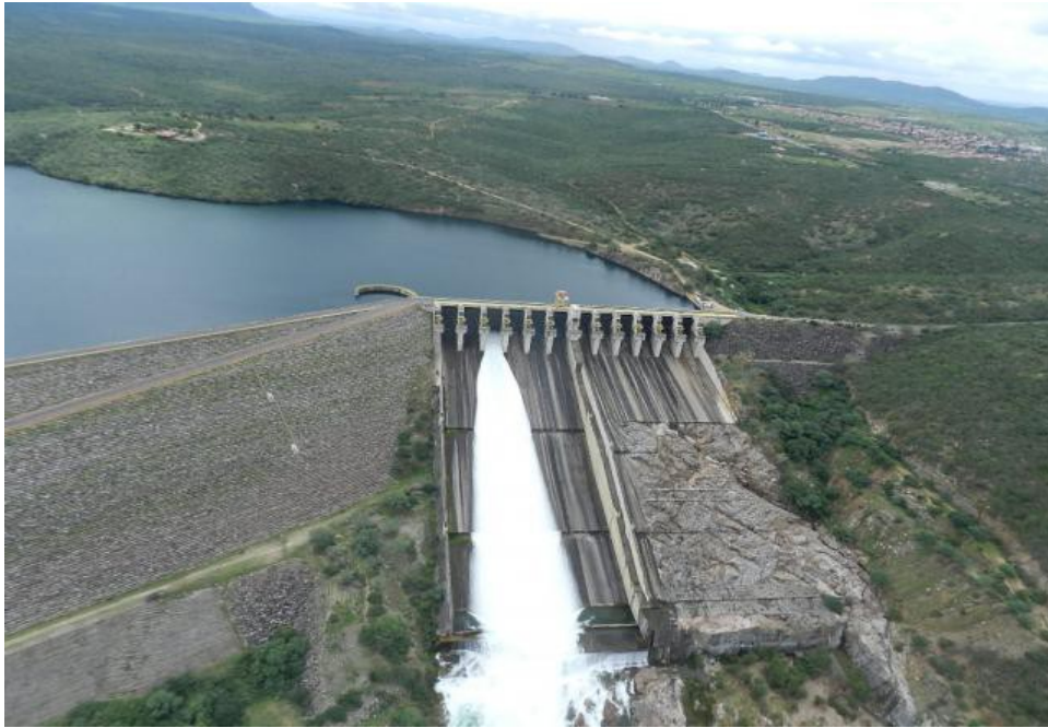
Figura 11: Vertedouro da UHE Xingó. Fonte: IBAMA.
