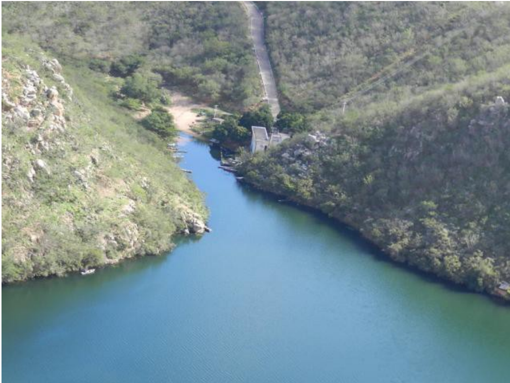
Figura 7: Sistema de captação de água do São Francisco próximo ao município de Delmiro Gouveia – AL. Fonte: IBAMA.
