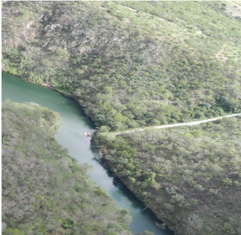
Figura 9: Sistema de Captação de água do rio São Francisco, próximo ao município Olho d'água do Casado-AL. Fonte:IBAMA.
