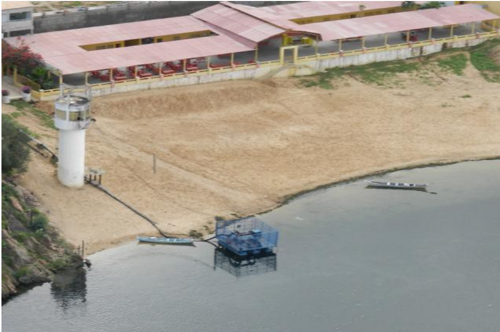
Figura 17: Sistema de captação de água em Pão de Açúcar-AL. Fonte: IBAMA.
