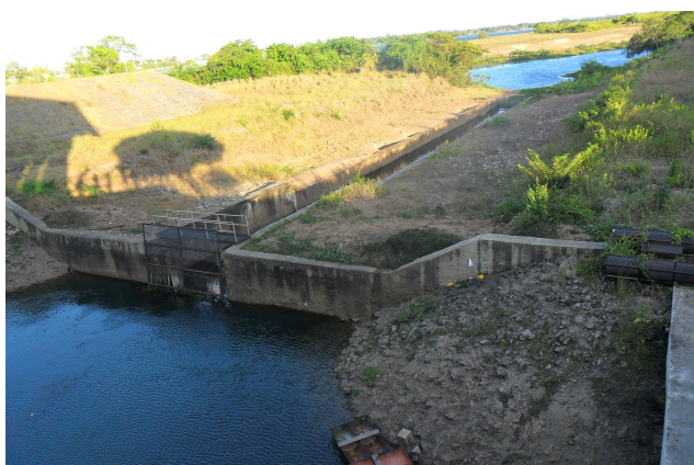
Imagem 15: Propriá/SE, DESO, canal de aproximação no ponto de captação
