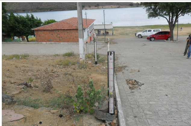
Imagem 07: Curralinho/SE Régua limnimétrica para acompanhamento do nível do rio
