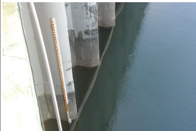
Imagem 14: Propriá/SE, DESO - Régua para medição de nível no ponto de captação
