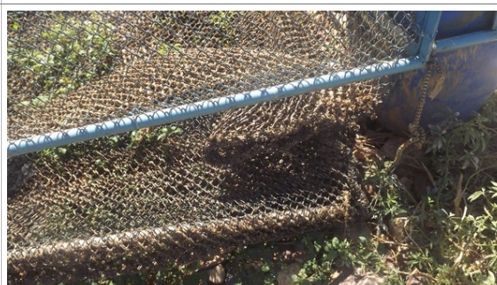
Foto 7: Detalhe de um tanque-rede com incrustação de moluscos na ACRIFEIXE. Coordenadas: 9°24'9.05"S e 40°48'52.93"W.
