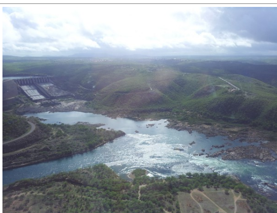
Foto 32: Vista da área de restituição das águas do reservatório da UHE Xingó. Coordenadas: 9°38'6.96"S e 37°47'39.74"W.
