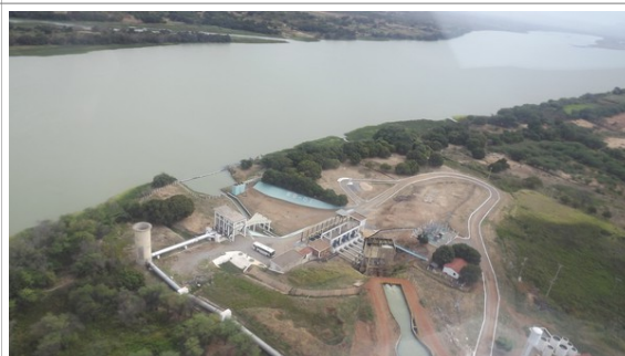
Foto 19: Vista da captação do projeto de irrigação Curacá. Coordenadas: 9°23'40.89"S e 40°26'56.64"W.
