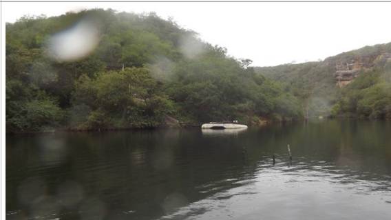
Foto 41: Captação da CASAL no reservatório de Xingó. Coordenadas: 9°30'31.49"S e 37°51'25.47"W.
