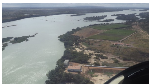
Foto 20: Vista da captação para irrigação na margem direita do rio São Francisco. Coordenadas: 9° 3'45.37"S e 40° 2'56.32"O.
