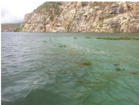
Foto 44: Mancha no reservatório da UHE Xingó. Coordenadas: 9°26'13.78"S e 38°9'44.84"W.
