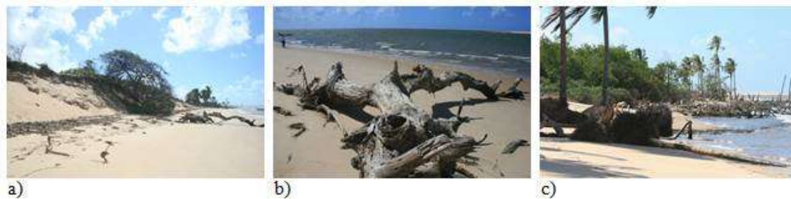
Figura 5: Evidências de erosão na foz do Rio São Francisco, margem sergipana. a) escarpa na dunas e raízes expostas; b) árvores tombadas; c) coqueiros caídos e raízes expostas.
