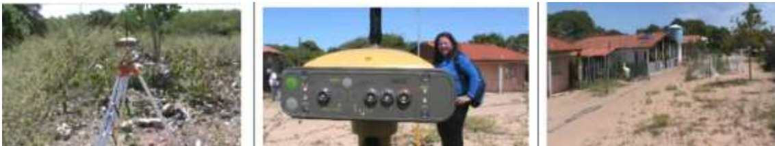
Instalação da Estação Inicialização Base GPS
