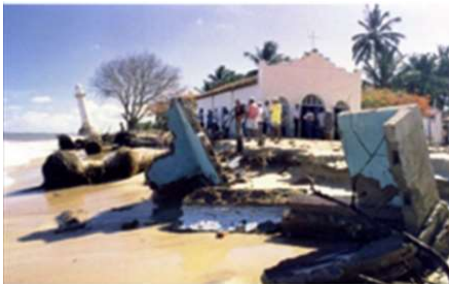
Figura 30.6 – Início da Destruição do Povoado Cabeço (1998). Erosão chegando na linha da Igreja. Fonte: Autos do Processo Nº 002809-27.2002.4.05.8500.
