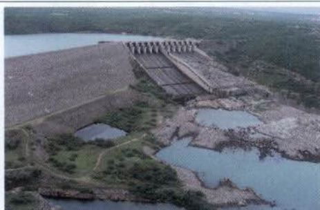
Figura 33. Barragem da UHE Xingó, com o reservatório da usina a montante e o rio São Francisco a jusante. Notar as estruturas do vertedouro da usina.
