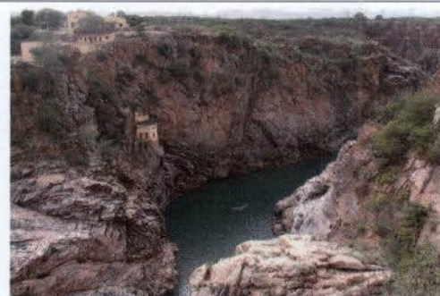
Figura 19. Complexo Paulo Afonso. Cânion no antigo leito do rio São Francisco, a jusante da cachoeira de Paulo Afonso, mostrando a usina de Angiquinho, primeiro aproveitamento hidrelétrico em Paulo Afonso/BA.
