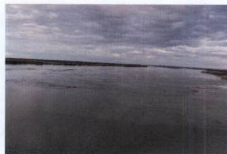
Figura 4. Rio São Francisco, imediatamente a jusante da barragem da UHE São Francisco.
