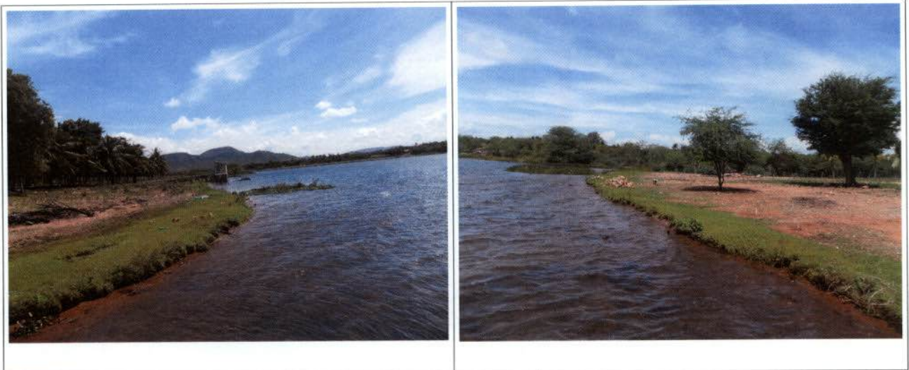
Fotos 19 e 20 – Processos erosivos UHE Paulo Afonso – Área 2 .
