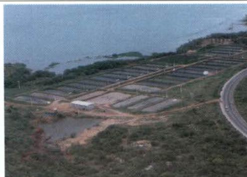
Figura 15. Reservatório da UHE Itaparica. Notar os tanques de piscicultura na APP do reservatório.
