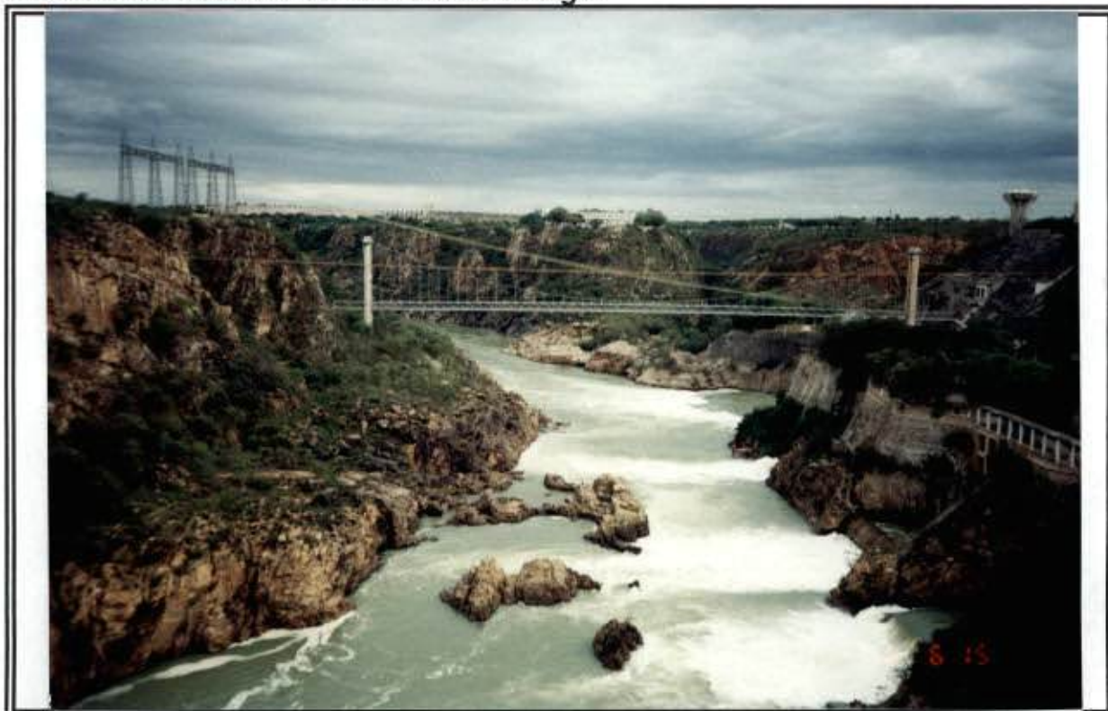
Foto 6 – UHE's Paulo Afonso I, II, III e IV. Vazão efluente das usinas I, II, III e IV de montante para jusante respectivamente.
