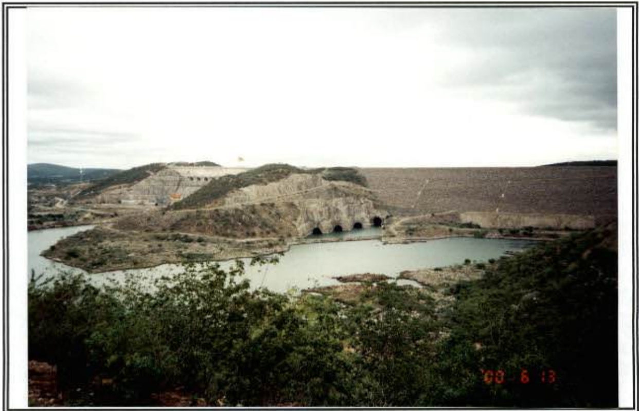
Foto 1 –UHE Xingo, vista à jusante.
