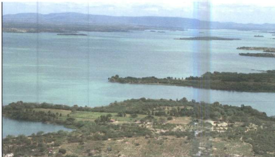
Rervatório de Moxotó
