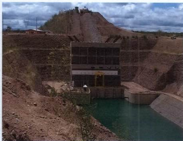
Captação do Projeto de Integração do Rio São Francisco – Eixo Leste – instalada na margem esquerda do Reservatório de Itaparica, entre os municípios de Petrolândia e Floresta (08°46'23.79"S, 038°22'4.50"O), esta estrutura ainda se encontra em estágio pré-operacional.
