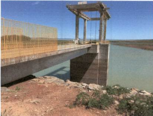
Estação de Bombeamento do Projeto Nilo Coelho em Sobradinho.- Captação operando normalmente
