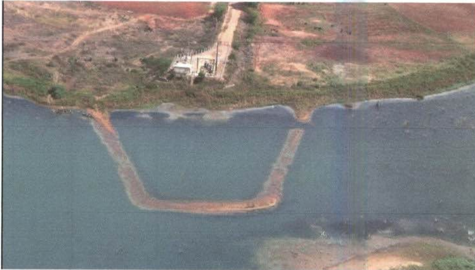
Captação PI Apollonio Salles-PE
