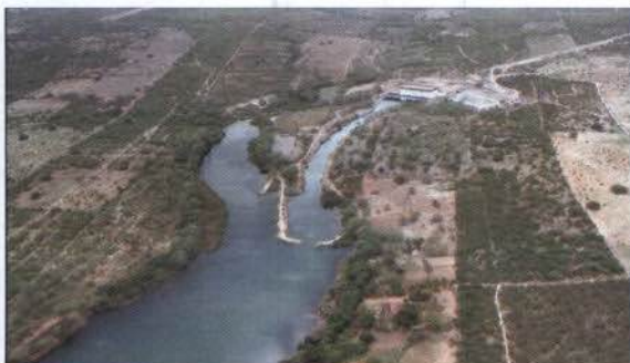
Captção do Canal do Sertão Alagoano, instalada às margens do Reservatório de Moxotó ( 9°20'24.37"S, 38°11'38.39"O)
