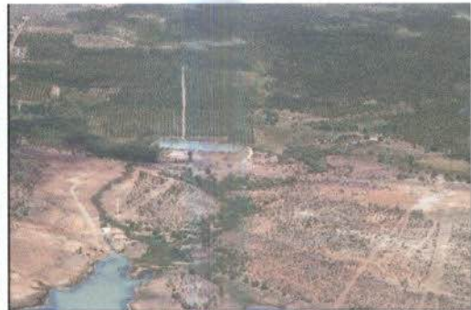
Captação e reservatório pulmão de perímetro irrigado no município de Rodelas – BA, na margem direita do Reservatório de Itaparica ( 8°51'29.35"S, 38°44'11.73"O)
