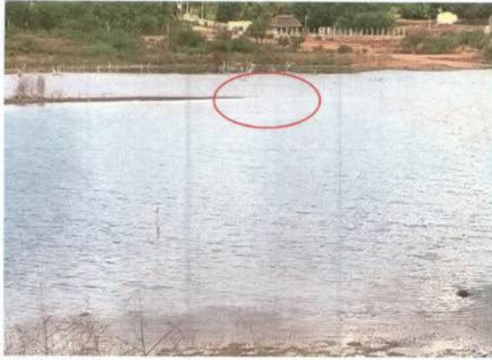
Estação de Bombeamento EB-01 – esta instalação capta água no Reservatório de Itaparica (08°59'1.55"S, 038°14'51.87"O) para suprimento a parte da cidade de Petrolândia – PE e do Perímetro Irrigado Apolônio Sales, na zona rural deste município. O seu funcionamento já ocasiona a formação inicial de vórtice.
