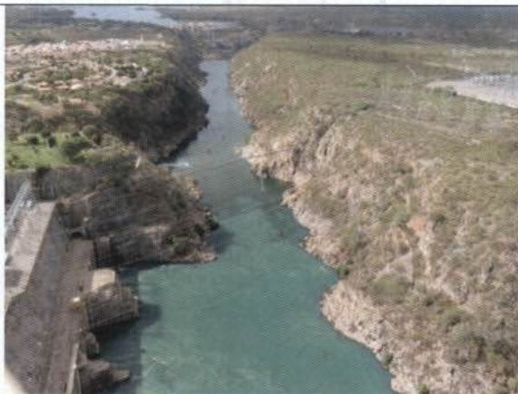
Imagem 39: Mancha próximo a USQ
