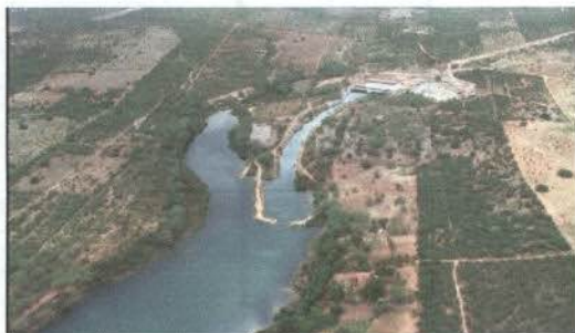
Captação do Canal do Sertão Alagoano, instalada às margens do Reservatório de Moxotó ( 9°20'24.37"S, 38°11'38.39"O)
