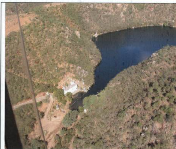
Imagem 56: Mancha no Braço de Captação de Delmiro Gouveia-AL
