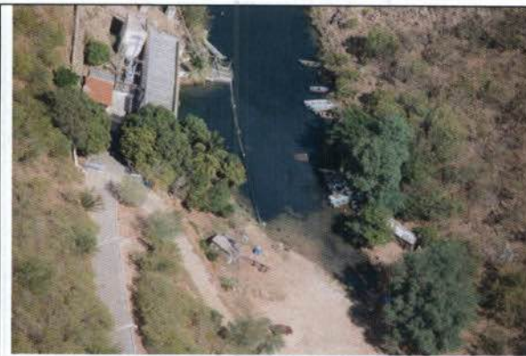
Imagem 35: Captação de Delmiro Gouveia-AL
