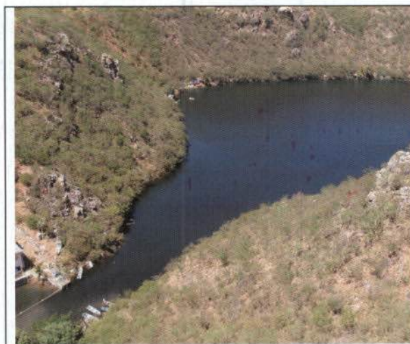
Imagem 54: Mancha no Braço de Captação de Delmiro Gouveia-AL
