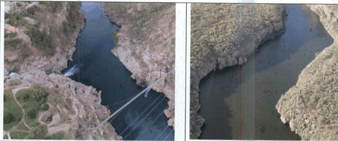
Imagens 17 e 18: Trecho do reservatório de Xingó tomado pela Mancha com lançamento de efluentes
