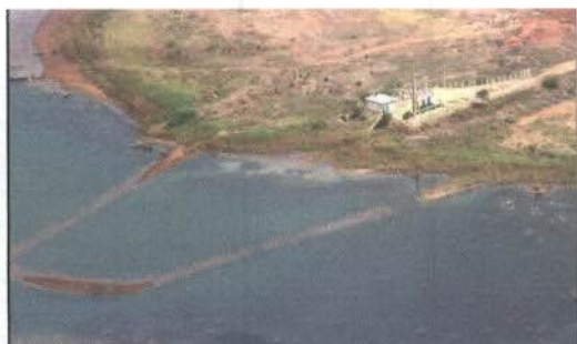
Uma das captações do Perímetro Irrigado Apolônio Sales e da cidade de Petrolândia – PE ( 8°59'1.67"S, 38°14'51.68"O)
