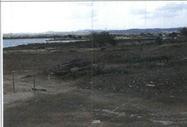
Imagem 27: São Brás/AL, Lagoa Comprida, margem esquerda, ocupação da calha do rio
