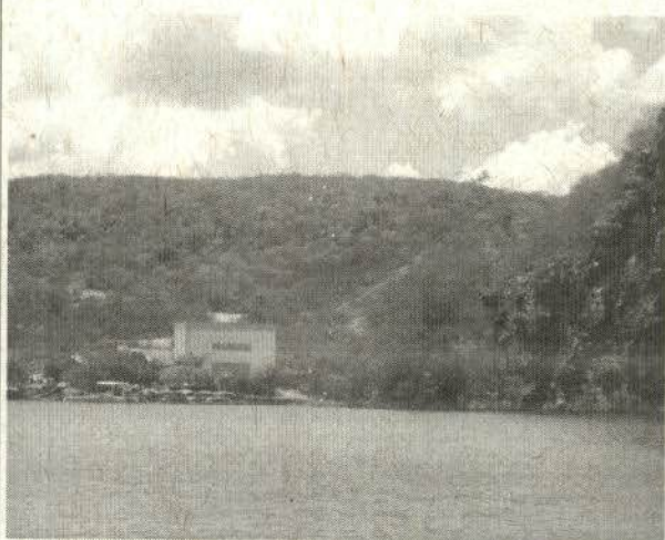
FOTO 58: Restaurante a margem do reservat6rio.
