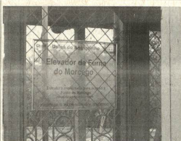
FOTO 13: Vistoria à Usina Hidrelétrica Angiquinho - elevador desativado.
