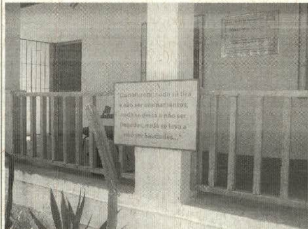
FOTO 18: Local do escritório da usina Angiquinho - Delmiro Gouveia-AL.
