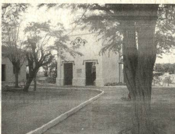
FOTO 16: Casa de força da Usina Angiquinho.
