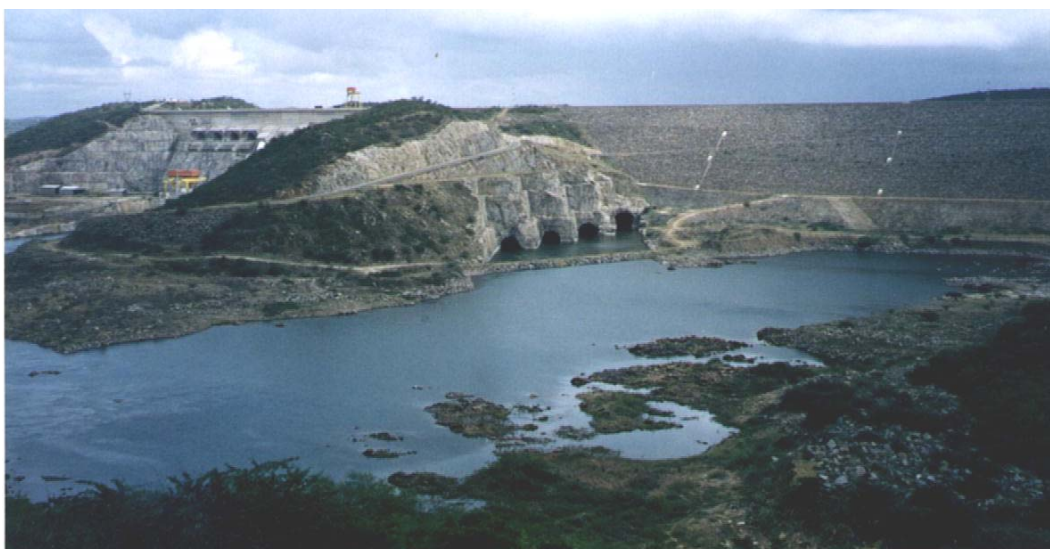
Foto 1. Barragem da UHE Xingó
